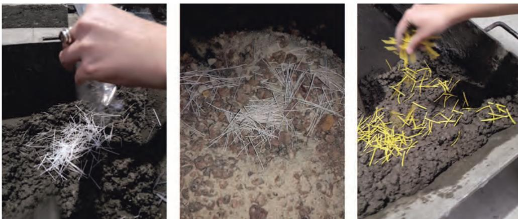
Imagen 15\_Elaboración de hormigón: incorporación de fibras al amasado
