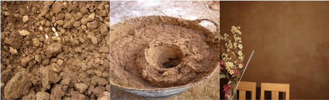
Figuras 66, 67 y 68\_ Tierra para revoque, preparación del revoque de tierra, revoque de tierra ejecutado en un paramento.
