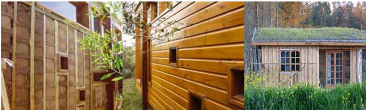
Figura 115\_ Alma del muro a revestir. Vivienda experimental. Punta Rubia (Uruguay). Arquitecto: Javier Márquez. 2006
