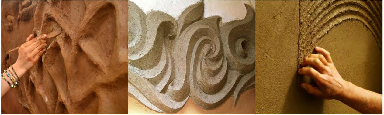
Figuras 89, 90 y 91\_ Diferentes revoques modelados en estado húmedo
