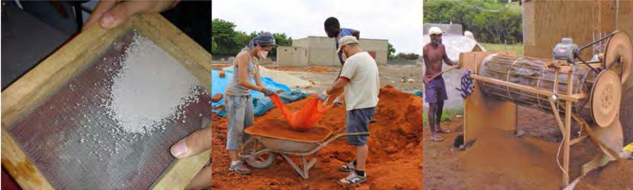
Figura 43\_ Tamizado manual, tamiz individual.
