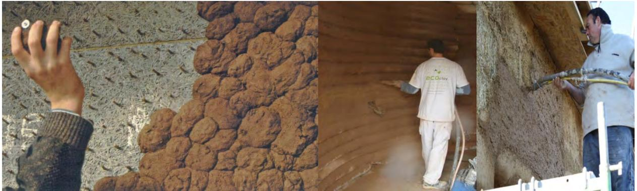
Figura 92\_ Revoque lanzado.
