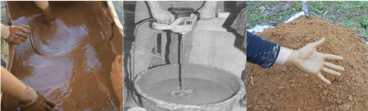
Figura 46\_ Mezclado manual de la barbotina.
