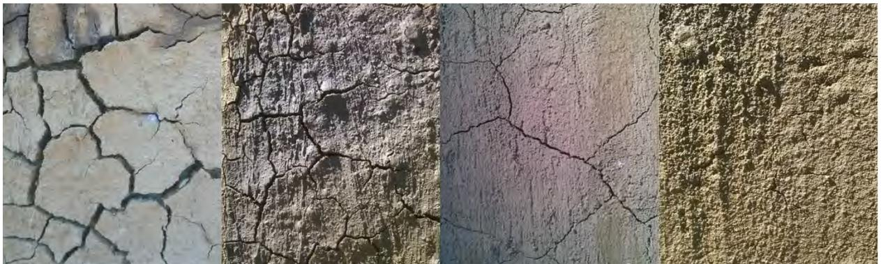
Figuras 62, 63, 64 y 65\_ Diferentes revoques y cuidados de secado.
