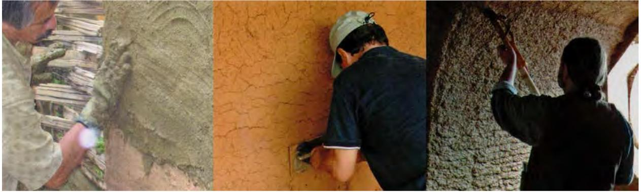
Figuras 59, 60 y 61\_ Diferentes métodos de ejecución: aplicado con la mano, aplicado con llana, proyectado con bomba.
