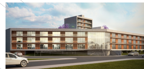
Fachada del Complejo donde se observa el Hall de ingreso de triple altura.
