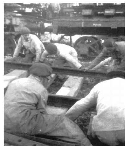
◀ La piedra elemento fundamental para la instalación de terraplenes y vías
