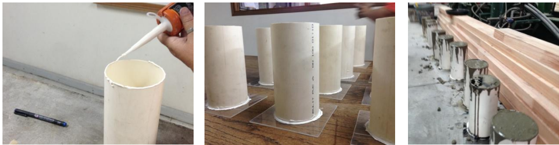
Figura 16: Moldes pegados con Sikabond® a base acrílica
