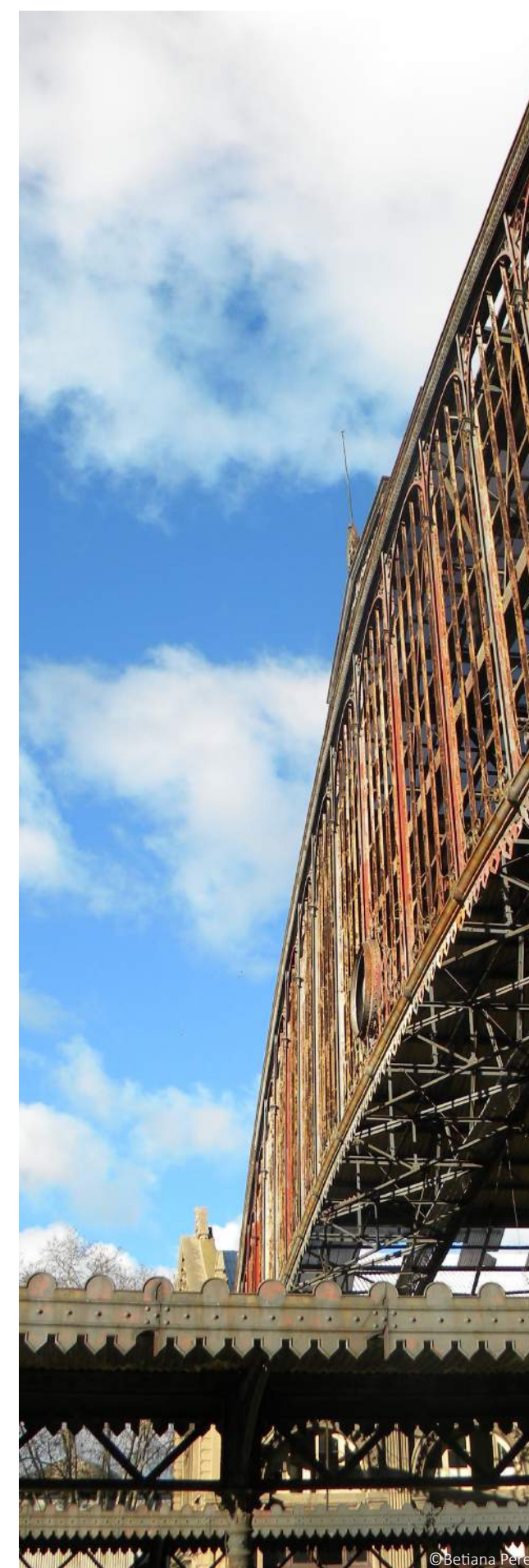
Estación central General Artigas AFE / Montevideo / Uruguay
