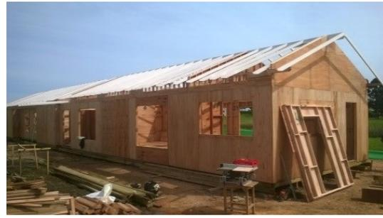
Figura 22 – montaje de paneles y cubierta
