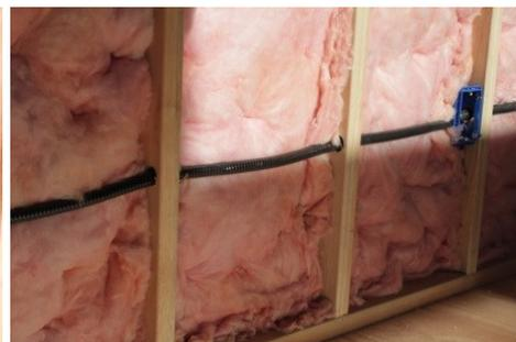
Figura 24 – colocación instalación sanitaria y eléctrica
