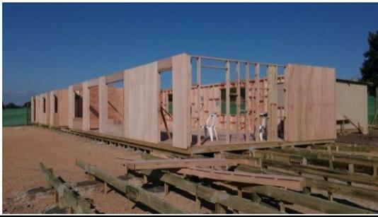
Figura 21 – montaje de paneles
