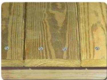
Su composición es 2/3 partes de cobre y el resto de cloruro de dodecilmetilamonio. La formulación del tipo B tiene una base amoniacal en cambio los tipos C y D son con base etanolamina y/o amoniacal.
