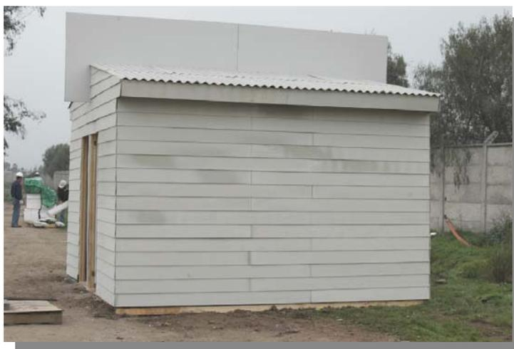
Fig. 7 - Muro cortafuego
