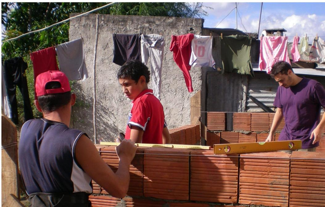
*Figura 20 - Avance de muros en sector de ampliación. Se puede ver al propietario y su hijo trabajando junto a uno de los estudiantes del equipo proyectista.*
