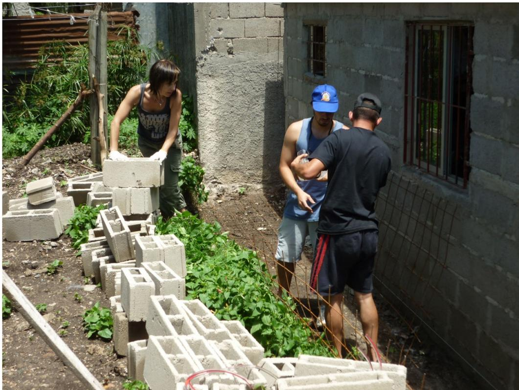
*Figura 17 -En obra: construcción del muro de contención.*
