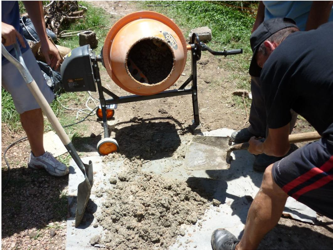
*Figura 16 - Dosificación y elaboración de primer hormigón para el muro de contención.*
