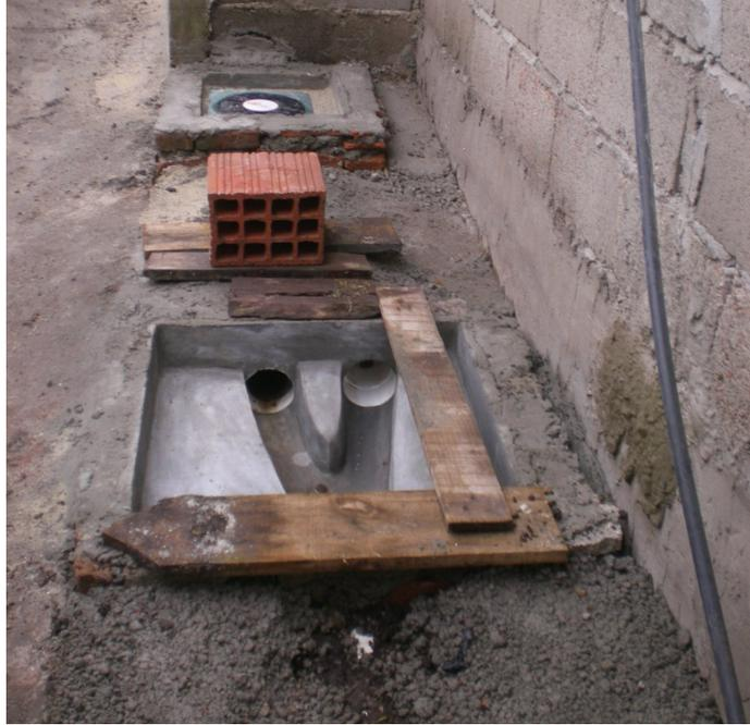
*Figura 18 - Inspector de Grasa y cámara de inspección 60x60 que une aguas primarias y secundarias.*
