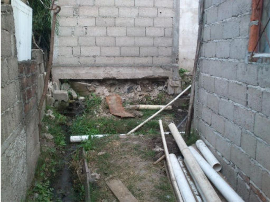
Figura 14 - Limpieza de terreno y canalización por cuneta lateral de aguas pluviales. Descubrimiento de los caños existentes de desagüe.
