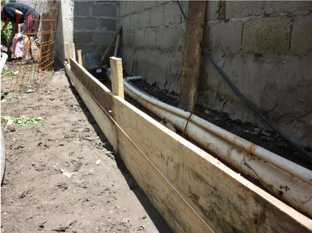
Figura 15 -Replanteo del muro de contención y vereda perimetral.
