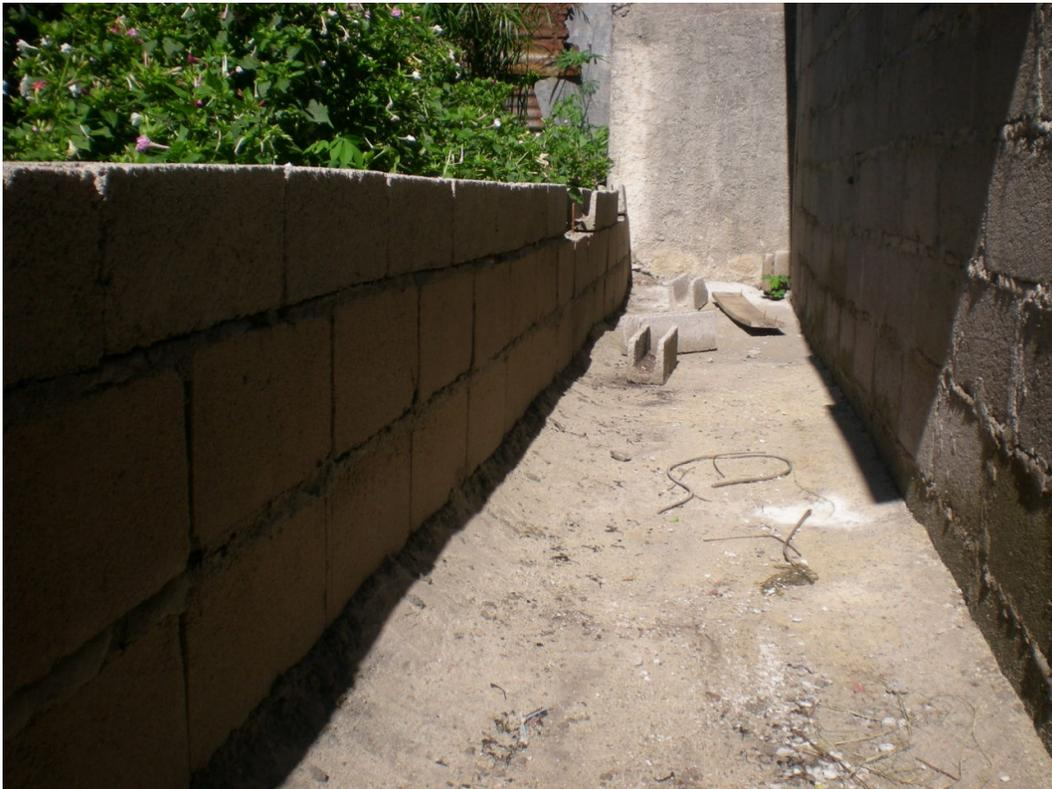
*Figura 19 - Muro de contención y vereda perimetral con pendiente para desagote de aguas pluviales del terreno y evita que aguas pluviales del terreno caigan hacia el terreno de la vivienda.*
