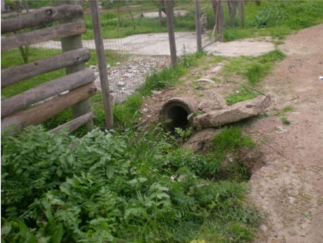
*Figura 12 - Cuneta de alcantarillado, esta zona de asentamientos en proceso de regularización se está regularizando con sistema separativo de saneamiento. Las cunetas cumplen una función estrictamente de desagüe de pluviales, pero la realidad demuestra que la gran mayoría de las viviendas vierten sus aguas de desecho directamente hacia la cuneta.*
