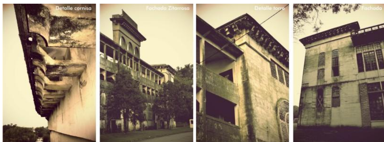
Figura 9 | Detalles de fachada
