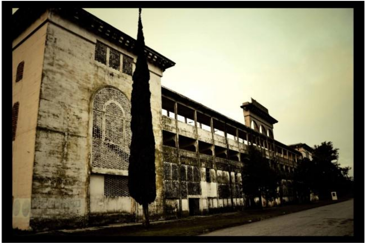
Figura 1 | Edificio Frontón de Pelota Real de San Carlos
