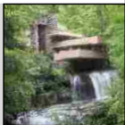
Casa de la Cascada
