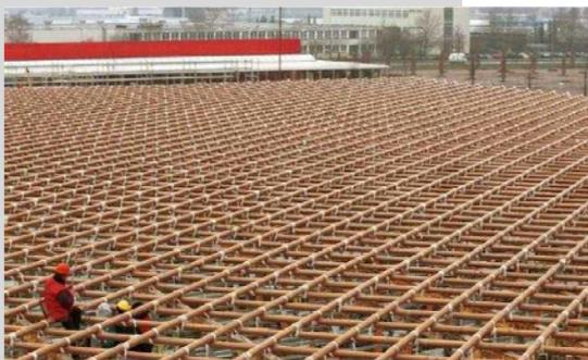
Es un procedimiento totalmente diferente de armar una estructura geodésica primero porque se utiliza barras de cartón en lugar de acero, algo en lo que Ban es innovador, pero por el otro lado en los domos geodésicos de acero, las barras se van colocando en el lugar final que ocupan en la estructura y no en el piso.
