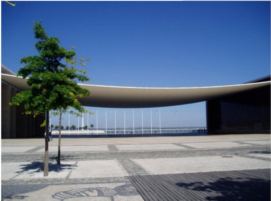
Cubre un espacio de 60 por 58 metros con un espesor de tan solo 20 centímetros, en la que se utilizó hormigón ligero pasando por su interior unos tubos por donde van los cables de acero de los que está suspendida desde una altura de 10 metros.
