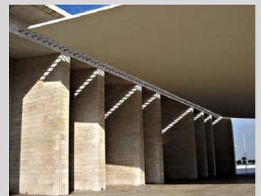
Separación de la lámina de los contrafuertes
