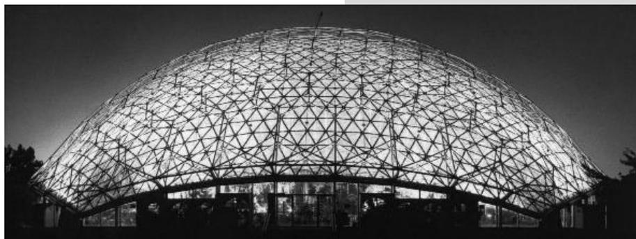
buscar un método o técnica que le permitiera construir una estructura eficiente. Decidió combinar la esfera por ser una geometría que podía encerrar un gran volumen con un área mínima junto a un sistema de barras que son los elementos
