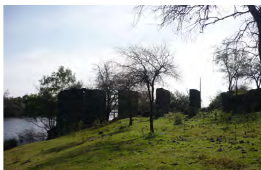
Figura 9 – Infraestructuras de navegación a dos niveles
