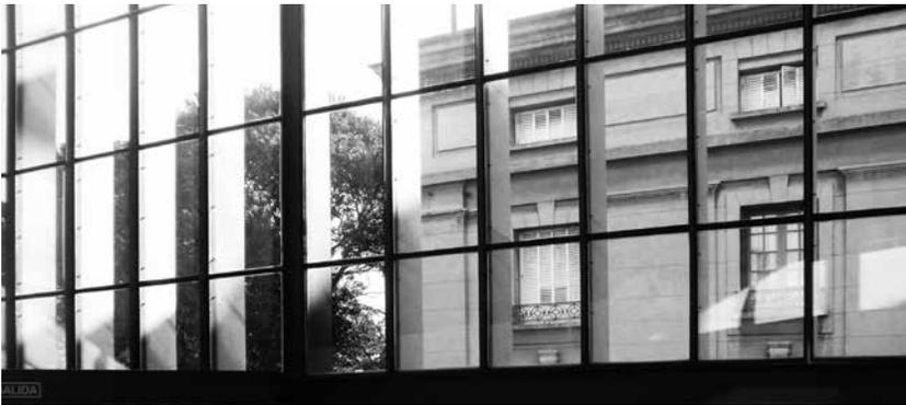
2.3\_007: Casa la Ricarda. Vista exterior de la serie de postigos con movimiento mecánico sincronizado, que configuran una especie de celosía fractal de lamas de lamas.
