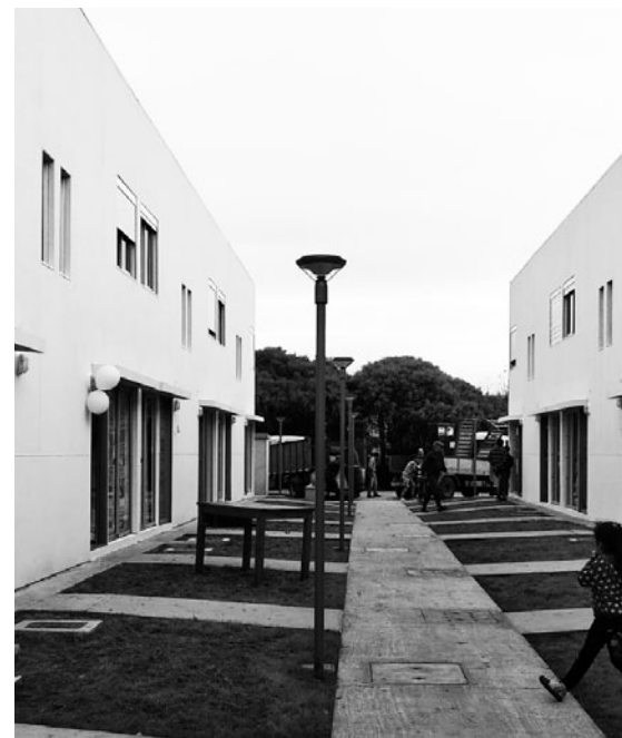
Obras para población afectada por inundaciones 2017 Chaplin, Paysandú
