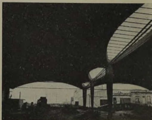
Bóvedas continuas descargando sobre arcos. Depósito para "El País".
