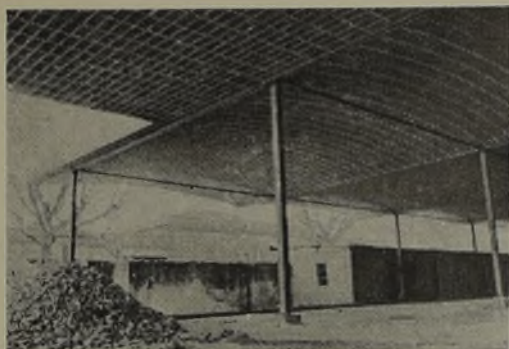
Bóveda de ladrillo en el edificio de Rondeau y Freire
