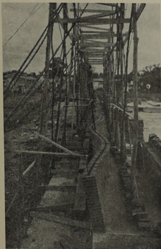
Iglesia de Atlántida. Construcción de los muros.
