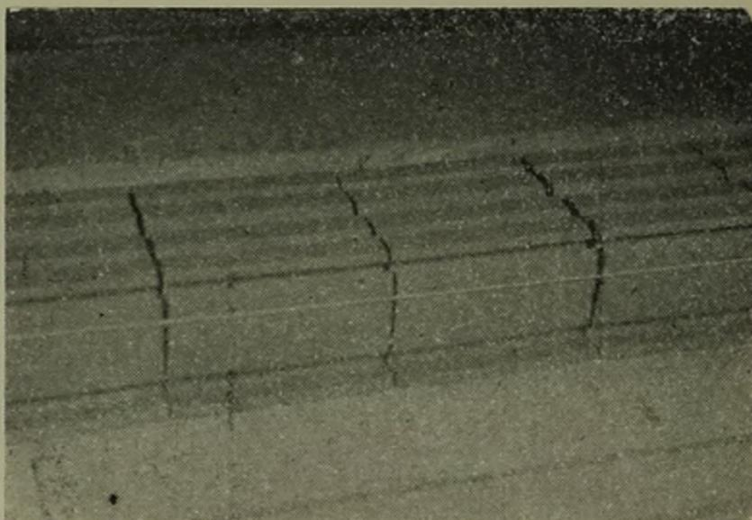
4º Sobre la primera vigueta, se ejecutó la segunda, previa capa de arena fina rociada sobre aquella. No se tomaron precauciones para que en la pieza quedaran desencontradas las juntas de una y otra vigueta, lo que hubiera disminuído los esfuerzos localizados que se generan en los hierros traccionados en esos puntos.
