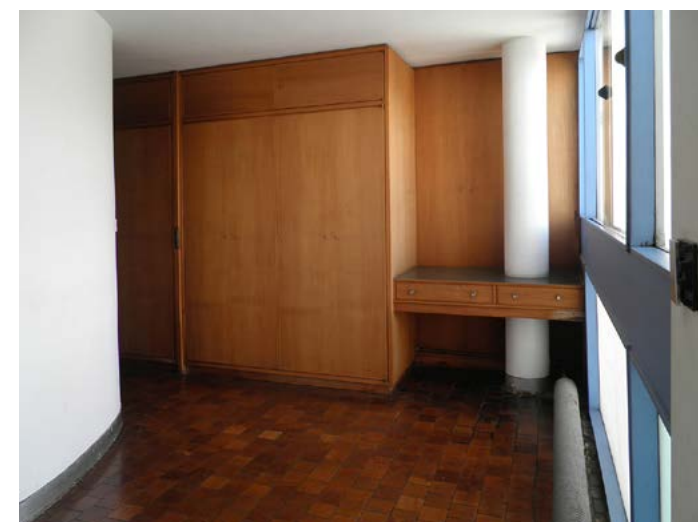
Los equipamientos fijos. Armario empotrado lineal que se extiende a lo largo de toda la vivienda en la planta de dormitorios. Vista de punto de articulación con la fachada posterior. Foto: Aníbal Parodi Rebella, 2012.
