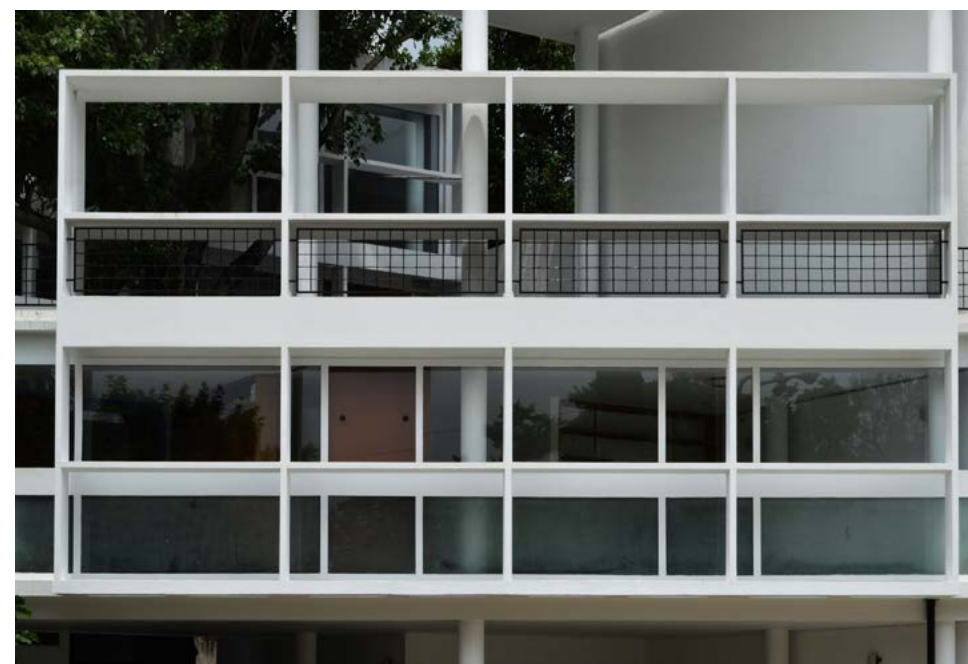
Los equipamientos fijos. El brise-soleil antepuesto a la fachada hacia la calle controla la privacidad y el asoleamiento de la crujía del consultorio y frente a terraza superior multiplica su profundidad y genera planos de apoyo para el cuerpo y para objetos en la contemplación de la plaza y la ciudad. Foto: Aníbal Parodi Rebella, 2014.
