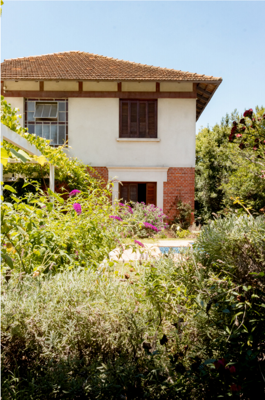
|57| Fachada Noroeste, vegetación.
