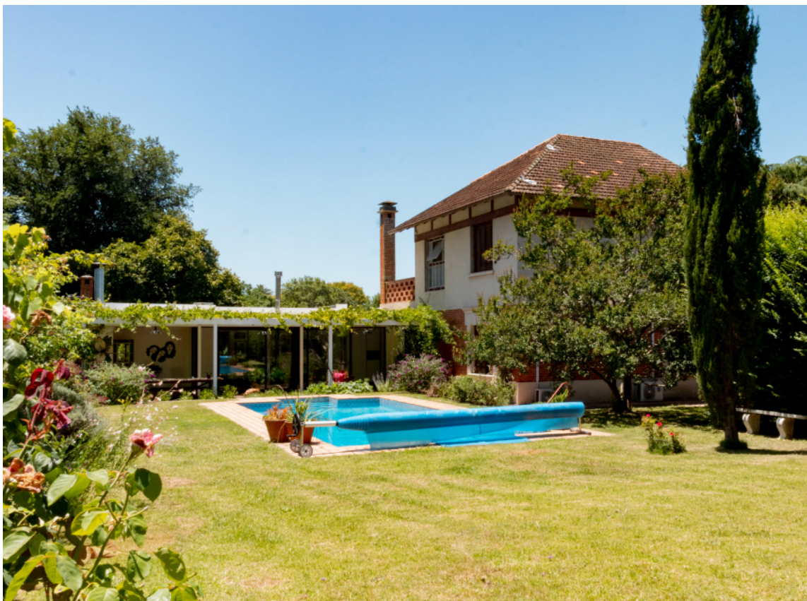
|32| Fotografía desde la ex viñedo. Vista de la fachada noroeste.
