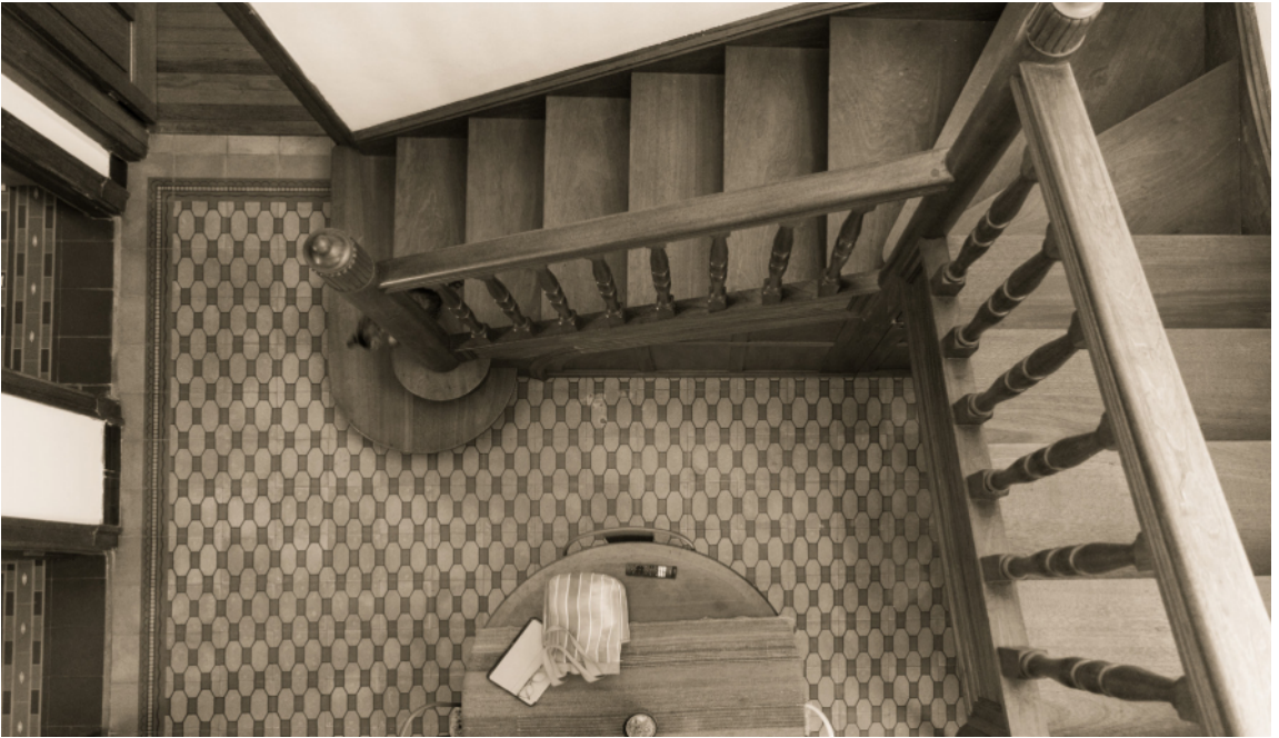
|29| Vista superior de la escalera.
