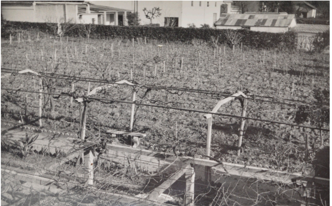
[28] Desde la terraza norte, viña, pórticos y parte de la glorieta.
