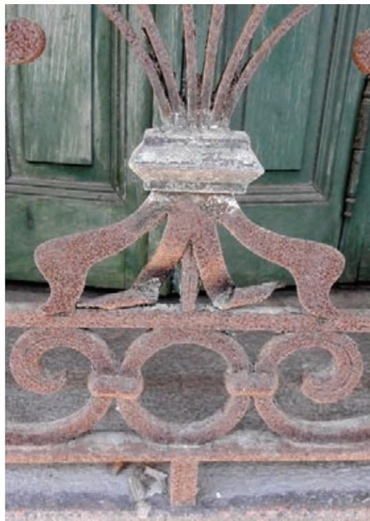
Elemento con un grado de corrosión avanzada y pérdida de material (izquierda)
