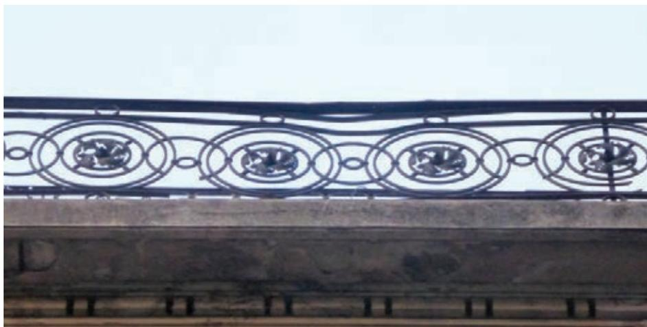
Deformación de elemento horizontal en baranda de pretil.
