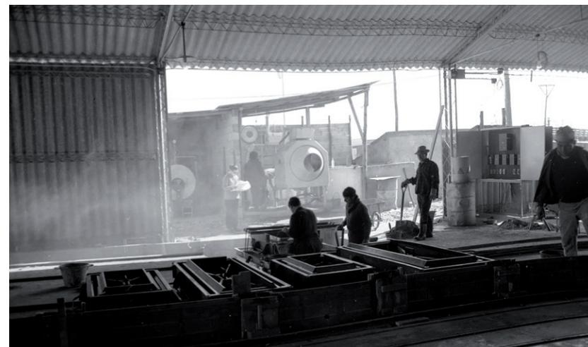
>> Planta de prefabricados del ccu en Mesa 1: hormigonera, planta de vapor, dosificadora de áridos y marcos de ventanas.
