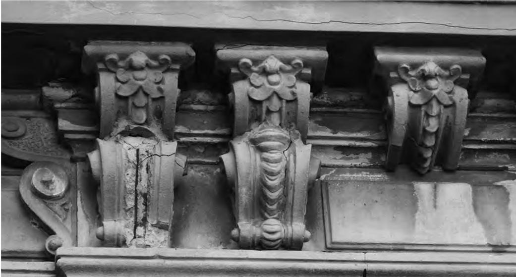
Fisuración provocada por corrosión de elementos metálicos ferrosos
