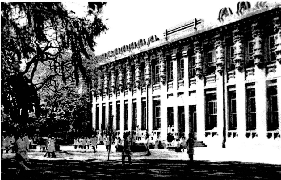
36. Fachada sobre el patio (1997)
