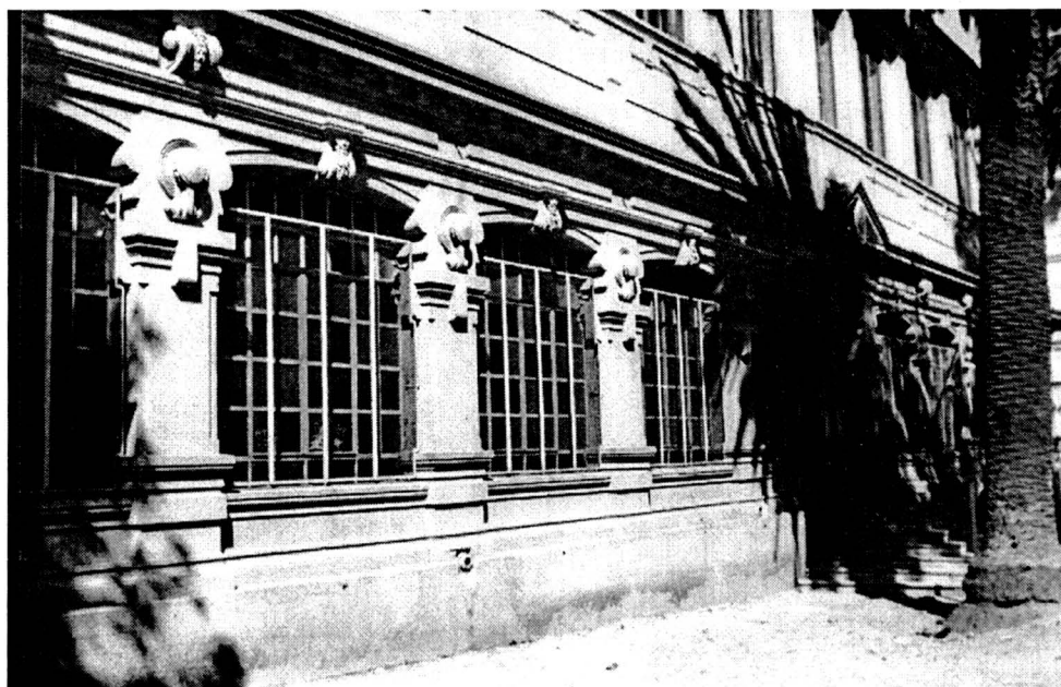
56. Detalle de la fachada principal (1997).
