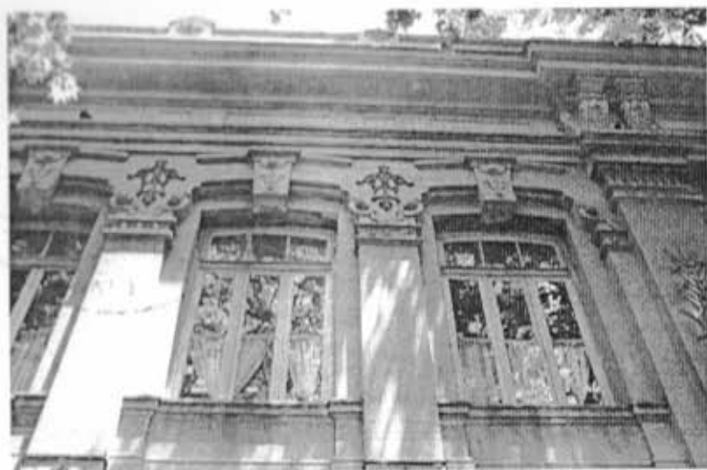
23. Coexistencia de elementos clásicos en el entablamento con modernistas en el coronamiento de los vanos.
