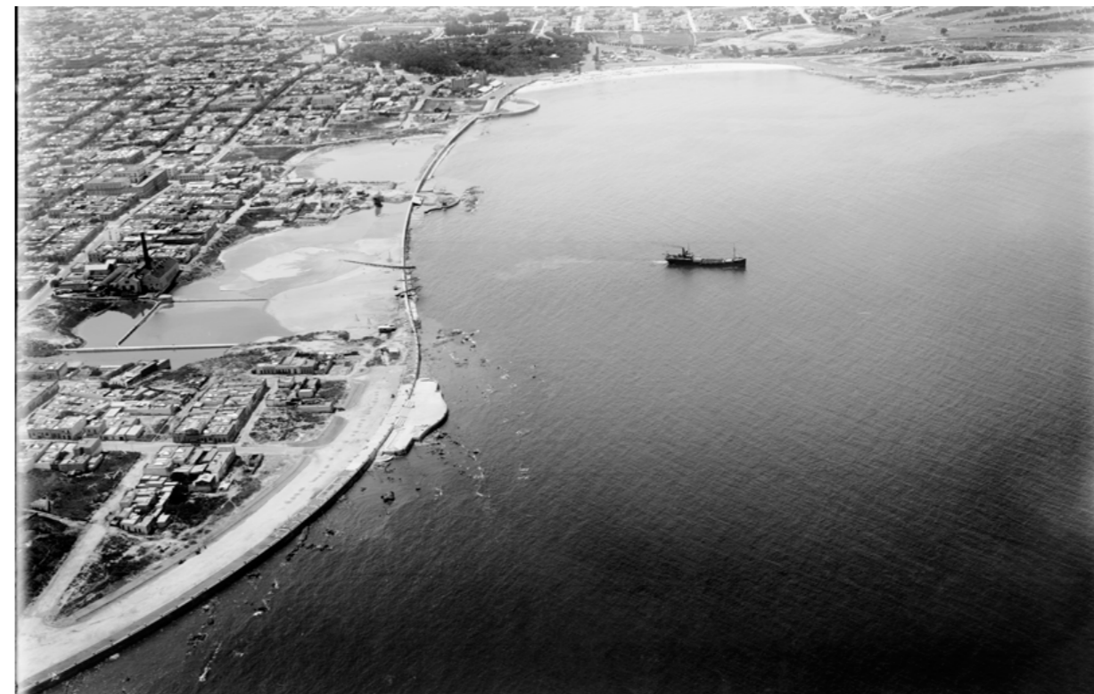
Vista aérea de las playas de Patricio y Santa Ana durante las obras de drenaje y relleno para la construcción de la Rambla Sur. Año 1930.
