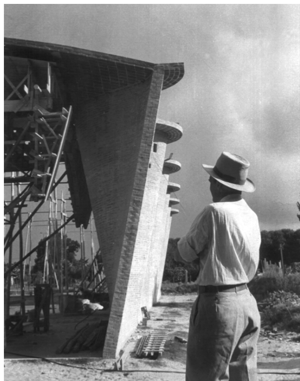
Eladio Dieste frente a la Parroquia de Cristo Obrero en construcción, a fines de 1959. Fotografía de M. Sassón.
