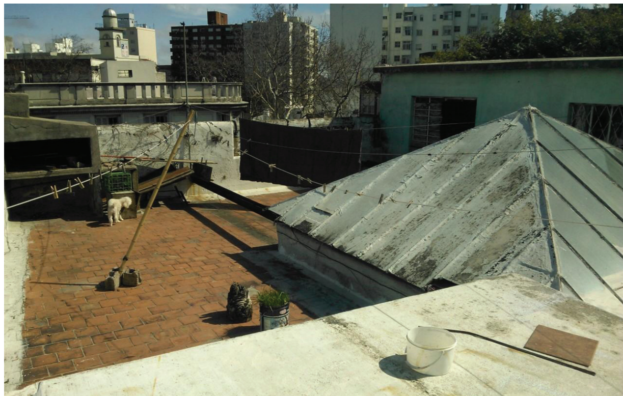
Azotea de una casa estándar en Montevideo
