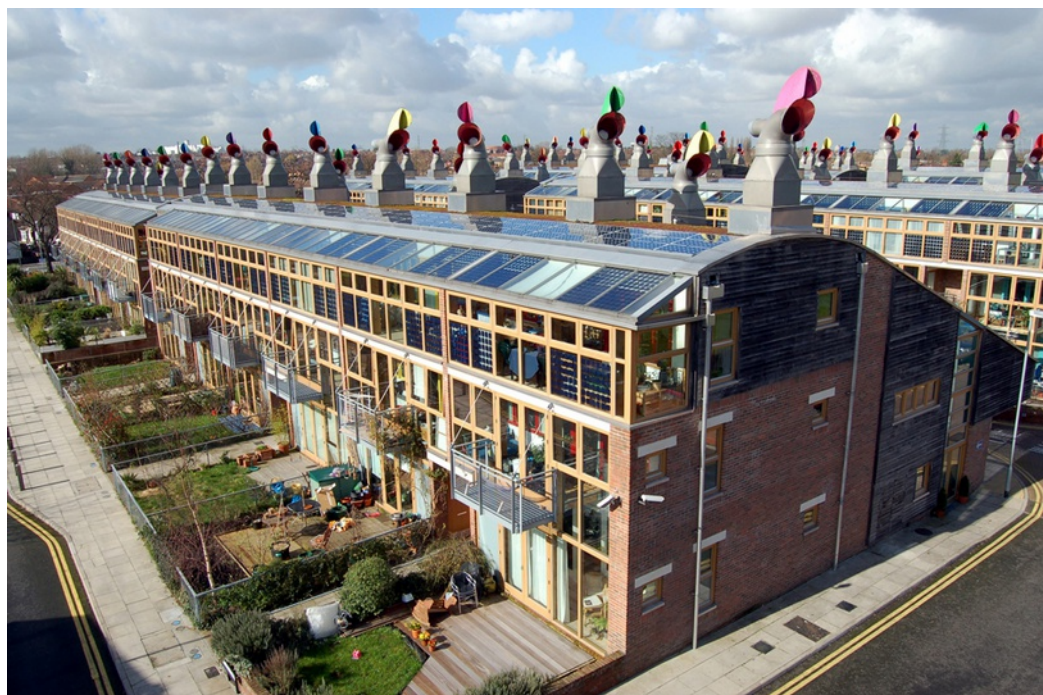
05. Vista aérea de BedZED. Foto: Tom Chance
