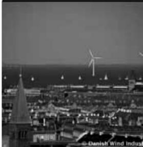
Consta de 20 aerogeneradores de 2 MW ubicados formando un arco. Con una potencia total de 40 MW, el parque eólico Puede generar 90 TWh al año, lo que Equivale al consumo energético anual de 20.000 hogares (Daneses), o al 3 Por Ciento del consumo eléctrico total de Copenhague.
