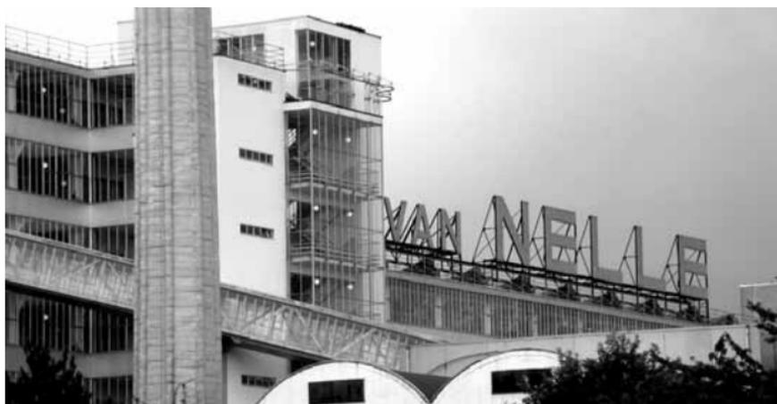
El edificio para la fábrica de tabaco se concibió de manera que las distintas funciones del ciclo de elaboración quedarán fielmente expresadas en la articulación del mismo. Inclusive los conductos que llevan el producto a los depósitos a lo largo del canal fueron integrados con audacia en la fachada de cristal. Estas pasarelas elevadas y el salón de té en la cubierta aparecen como rasgos particulares del edificio.
