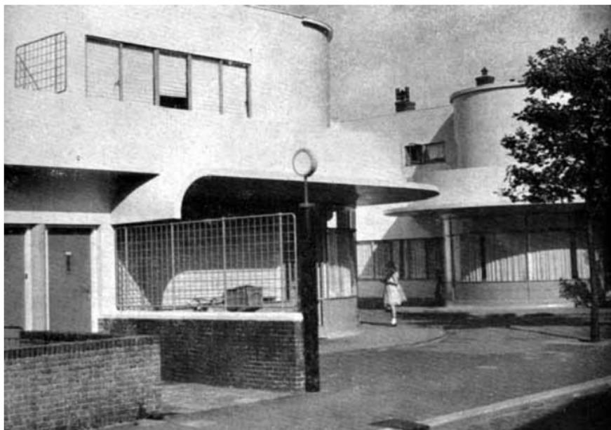
Las extremidades se curvan de modo que el ritmo lento no quede roto, sino que gire y vuelva sobre sí mismo. Todas las paredes se hallan revestidas de revoque blanco uniforme. El zócalo de ladrillo amarillo; el escalón delante de las puertas de ladrillo rojo, los umbrales de cemento gris; estos elementos junto a las puertas y los cercos pintados de azul, a los pilares grises entre las puertas, animan cromáticamente los dos edificios y acentúan el juego de luz y sombra.
