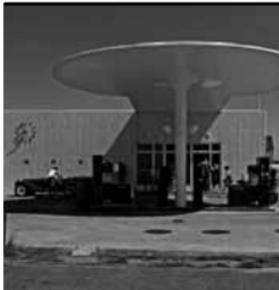
La estación de servicio en sí es una caja de hormigón, revestida con azulejos de cerámica de Meissen. El área de servicio es lo que hace que esta estructura se destaque: está cubierta por una concha ovalada de concreto, con el apoyo de una sola columna. Este diseño fue pensado originalmente como un prototipo de Texaco. Para evitar que la estructura se desmorone, ha sido objeto de una reforma urbana, en 2003 por Dissing Arquitectos + Weitling, en cooperación con la Municipalidad de Gentofte.
