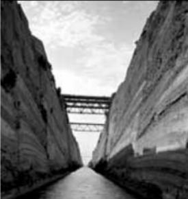
El Canal de Corinto es una vía de agua artificial que une el Golfo de Corinto con el Mar Egeo por el istmo de Corinto, abriendo esta vía al transporte marítimo. Mide 6,3 km de largo y se construyó entre 1881 y 1893. Fue construido siguiendo el antiguo trazado de Nerón. El canal evita el rodeo de 400 km alrededor de la Península del Peloponeso a los barcos pequeños, ya que sólo tiene 21 m de ancho y 8 de profundidad.
