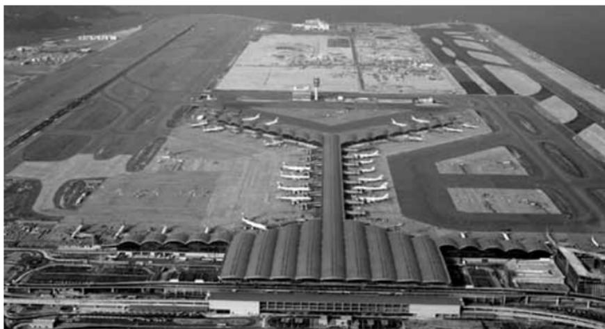
Constituye el primer aeropuerto del mundo en lo que refiere a volumen de tráfico internacional de pasajeros. La terminal tiene 1.5 km. de largo y 490000 m<sup>2</sup> de superficie. La cubierta cobija al edificio como una manta unificando sus diversas funciones y proporcionándole una identidad simbólica, además de ser el espacio público más grande jamás construido.
