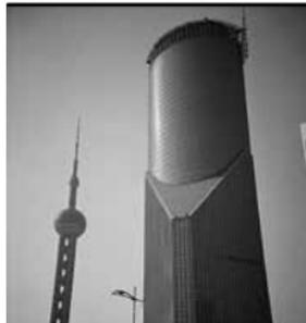
El conjunto interrelaciona un volumen irregular a modo de base al cual sobreviene la torre de planta elipsoide de 53 pisos. El cerramiento exterior es un curtain wall que permite el juego opacidad/transparencia en el día y la noche respectivamente. El coronamiento de la torre se ilumina deviniendo en un faro urbano, reivindicando la imagen fuertemente corporativa que pretende transmitir este nuevo centro administrativo/financiero del área de Pu Dong.
