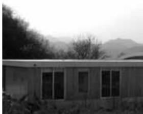
El sistema de construcción consiste en módulos de madera de 2,4 metros de altura y 90 centímetros de ancho (su espesor es de 45 o 70 centímetros según el caso), que actúan como estructura portante de la casa y como equipamiento a la vez. Al reducir la cantidad de materiales de construcción, disminuye el tiempo de obra real. El peso de estas unidades modulares (80 kilogramos) permite que sea posible transportar por un solo individuo, lo que brinda gran flexibilidad al proyecto.
