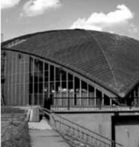
Contiene un pequeño teatro, un salón de conciertos, y cuartos de ensayo. Se observa su bóveda blanca agraciada: one-eighth de una esfera anclada en los estribos ocultados en tres puntos. En las tres caras, el cristal cubre el arco hacia arriba para resolver su cáscara concreta fina.
