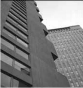
El complejo residencial consiste en dos torres de 25 pisos con fachadas de hormigón visto y ornamentos con reminiscencias orientales. La protrusión con forma de pagoda en sus esquinas fue lograda alternando dos pisos con balcones y dos sin balcones.
