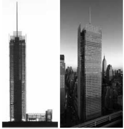
Guiado por la idea de la importancia de poder ver cómo fue construida la estructura, Piano dejó a la vista el acero de las vigas y columnas. Así, estos elementos estructurales, que normalmente se ocultan, son ahora elementos esenciales del diseño.
