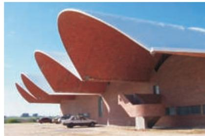
Fábrica Fagar, Colonia | Otro ejemplo de bóveda autoportante del Ing. E. Dieste
