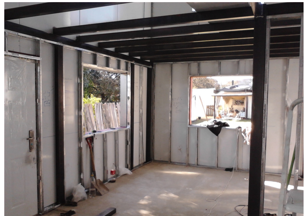
6- Vivienda en dos niveles. Se complementa con estructura metálica para lograr el entrepiso y la escalera. Se reviste interiormente con yeso, dejando una cámara entre la placa y el panel para canalización de instalaciones. Esto permite mayor libertad en la canalización de las mismas, y más rapidez en el proceso de montaje.
