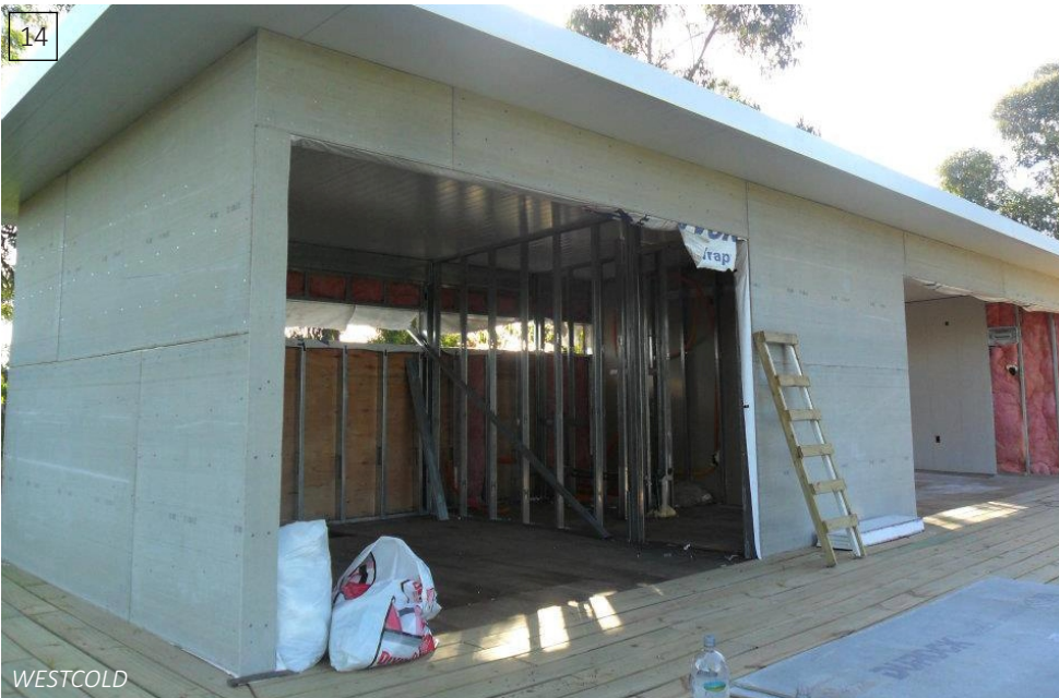
14- Revestimiento exterior con placa cementicia. Revestimiento interior con yeso. Tabiquería interior de yeso
