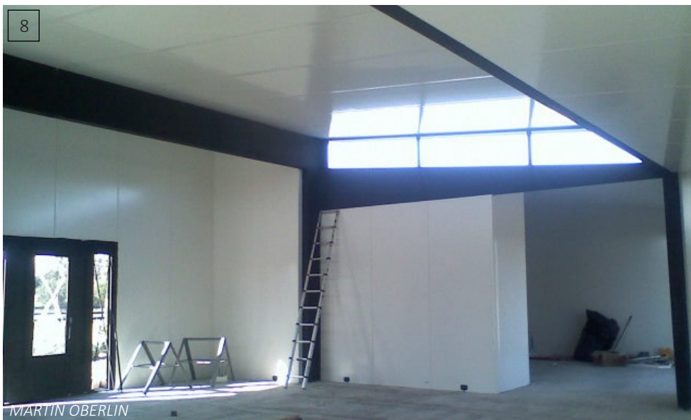
8- Complemento con estructura metálica para lograr grandes vanos y luces entre apoyos
