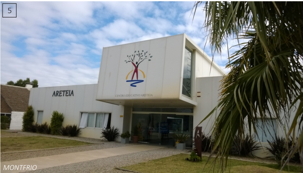
5- Colegio Areteia, Ciudad de la Costa. Combinación con estructura metálica para lograr un volumen que mensula sobre el acceso principal.
