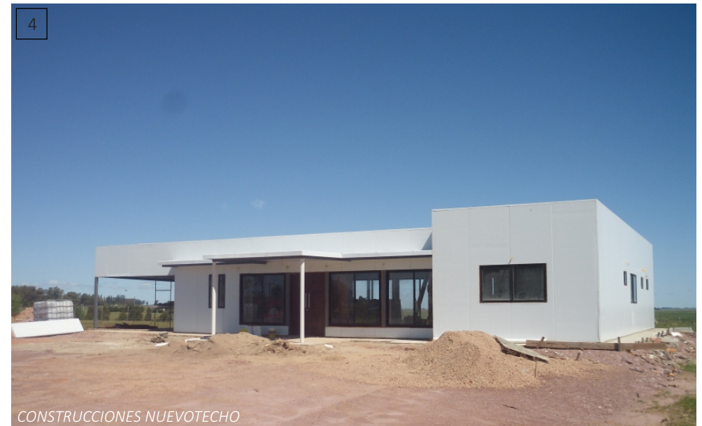
4- Combinación con estructura metálica para lograr grandes vanos y aleros
