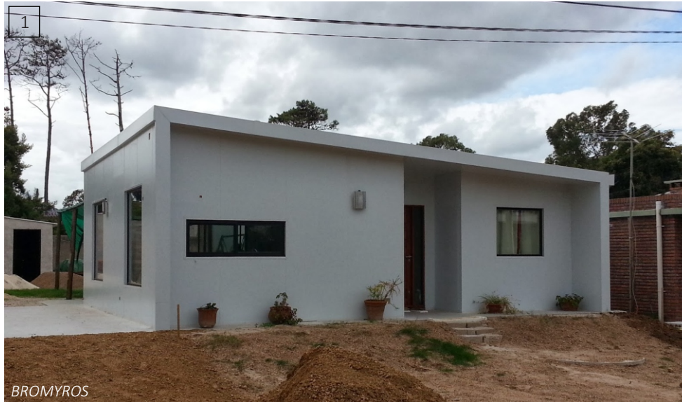
1- Vivienda resuelta íntegramente con paneles. Se diseña teniendo en cuenta el módulo de los mismos para tener juntas calculadas y un resultado armonioso.
