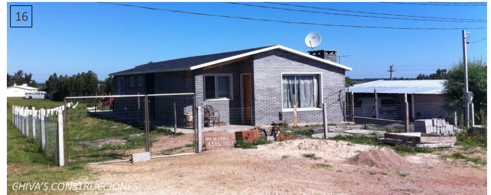
16- Revestimiento de cubierta con teja asfáltica con terminación de gravilla natural. En estos casos, no se utilizan paneles engrafados para la cubierta sino paneles de autoencastre simple, para lograr una superficie plana para la aplicación de las tejas. Las mismas actúan como una membrana, asegurando la estanqueidad de las juntas ante el pasaje del agua. La misma se adhiere al panel, y se fija mediante tornillos galvanizados autorroscantes de cabeza frezada
