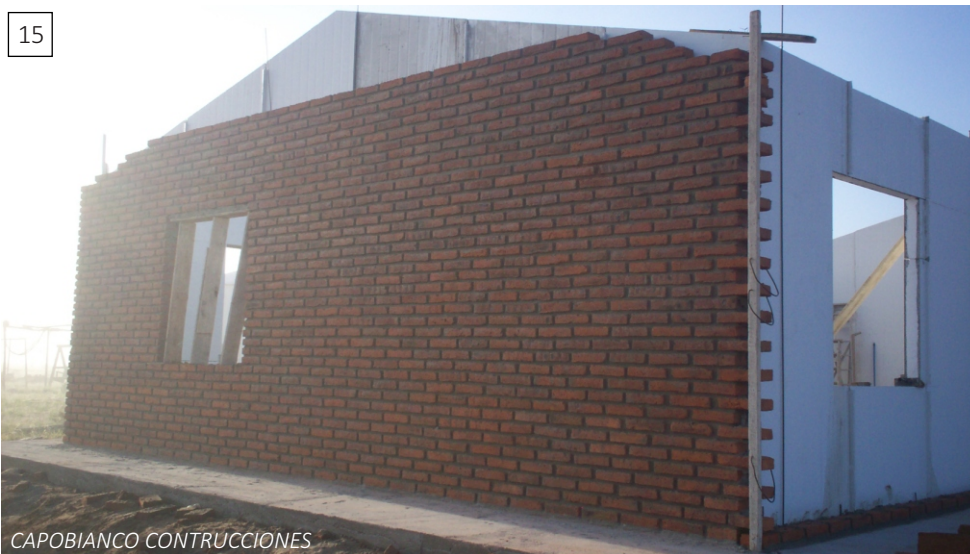
15- Revestimiento exterior con ladrillo. Deberán preverse algunas esperas o bigotes en los paneles, para generar un vínculo sólido entre ambos muros. Puede tratarse de ángulos de chapa prepintada previamente remachados al panel, que se metan en el mortero de toma y nivelación entre hiladas.
