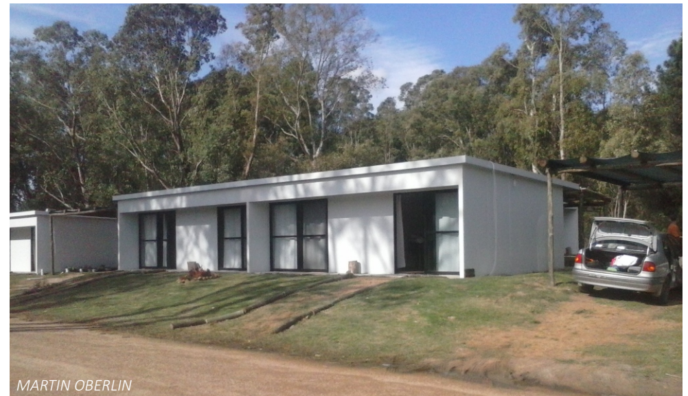
2- Vivienda resuelta íntegramente con paneles. Se utiliza un panel de pared acostado como viga, para lograr vanos de buen tamaño y un mayor alero frontal.
