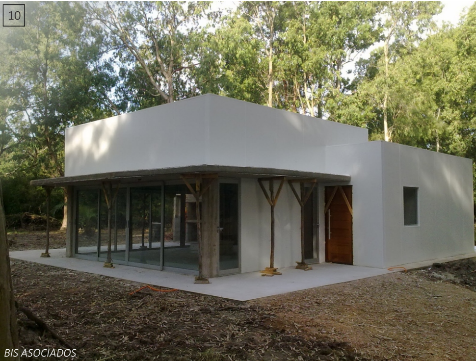
10- Complemento con estructura de hormigón armado.
