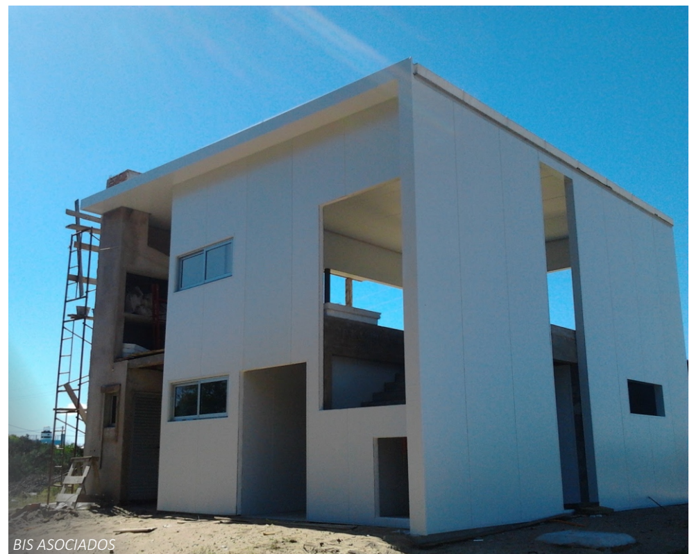
9- Vivienda de dos niveles. Complemento con estructura de hormigón armado
