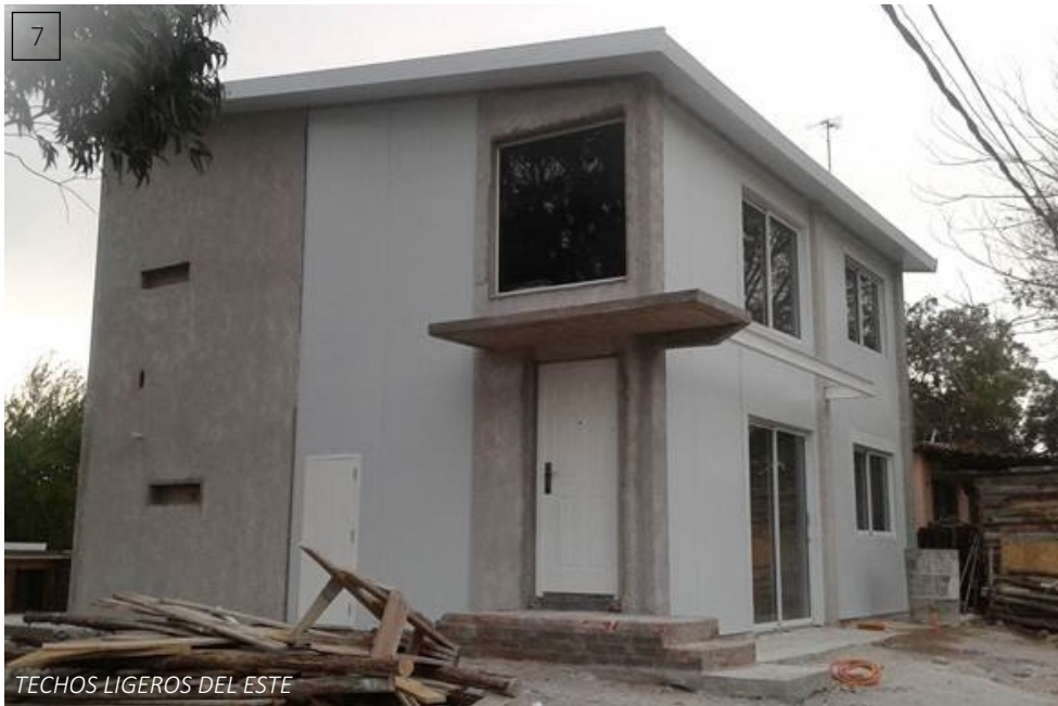
7- Vivienda en dos niveles. Complemento con estructura metálica y de hormigón armado.
