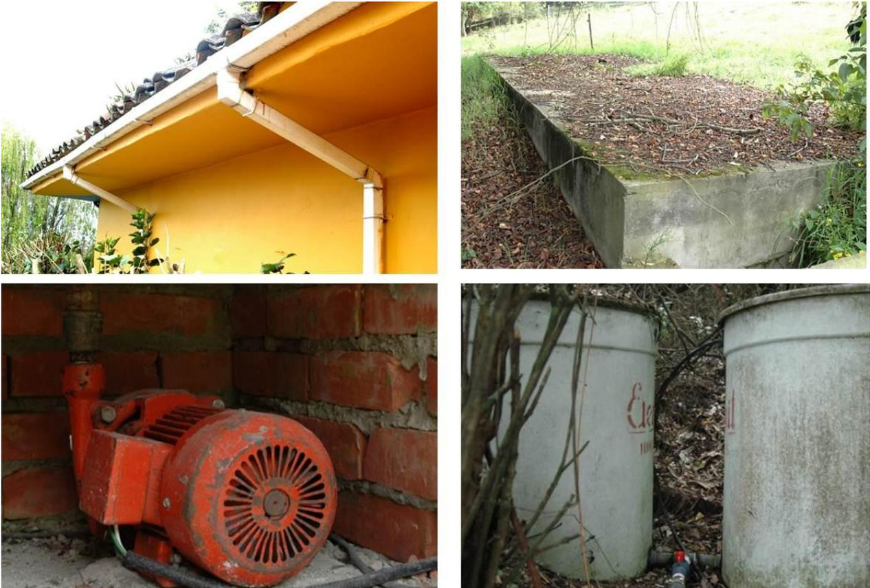
**Fig. 19.** Mecanismo de captación pluvial: canaletas (arriba e izquierda), depósito acumulador de hormigón armado (arriba y derecha), bomba (abajo e izquierda) y tanques acumuladores (abajo y derecha)
