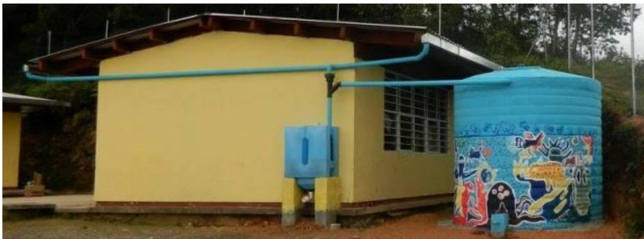
**Fig. 5.** Mecanismo de captación de agua pluvial para utilizar en usos no potables para una vivienda unifamiliar. Proyecto Isla Urbana, México. Se observa un mecanismo de captación de los primeros caudales a un depósito interceptor, incrementando la calidad del agua recogida.
