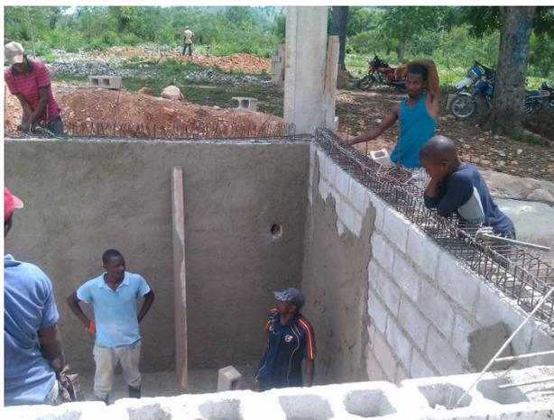
**Fig. 11.** Construcción de un depósito en bloque armado. Acumulando agua de forma subterránea, hay que tomar los recaudos necesarios para que ésta no se contamine
