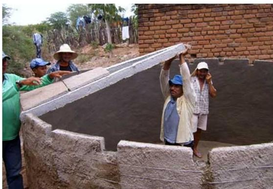
**Fig. 2.** construcción de un depósito acumulador de agua de lluvia para una vivienda unifamiliar.
