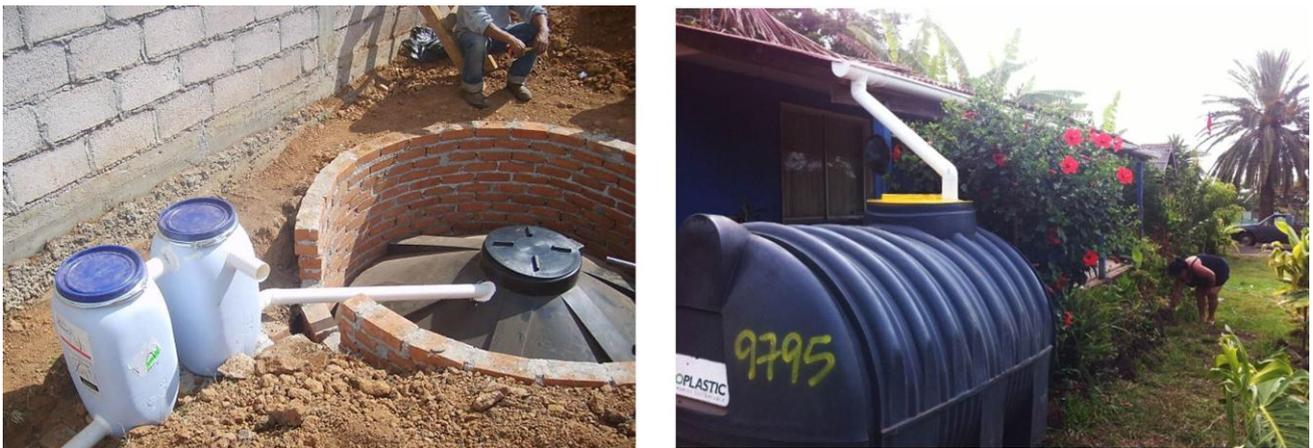
**Fig. 20.** Depósitos acumuladores e interceptores de agua pluvial: depósito bajo tierra (arriba) y depósito sobre nivel de suelo y en espacio exterior (abajo),
