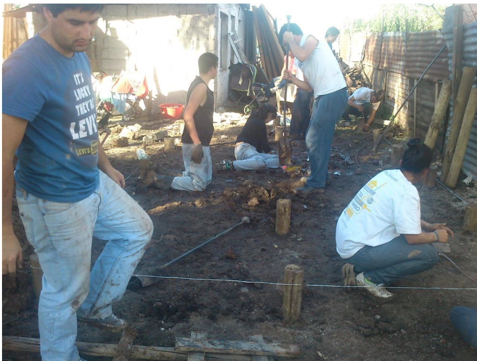
Voluntarios y familias construyendo una vivienda de UTPMP en el barrio 30 de Abril (Rafael esq. Tte Rinaldi).
