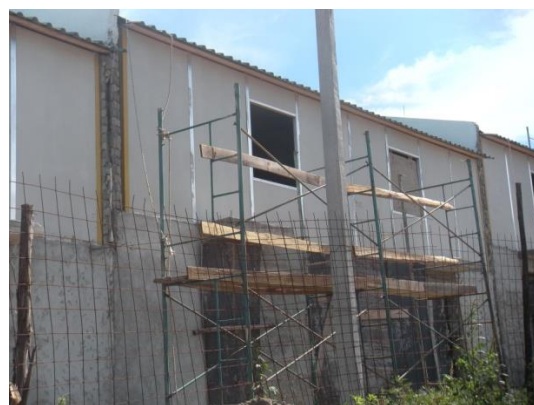
Solución habitacional del Plan Juntos (Luis Batlle Berres y Cno de las Tropas), construcción con componentes prefabricados..
