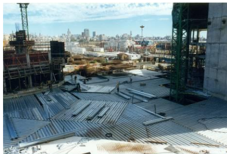
Figura 34 - Acopio de materiales en la obra
