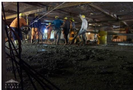
Figura 54 - Proceso de hormigonado losa de sala de máquinas
