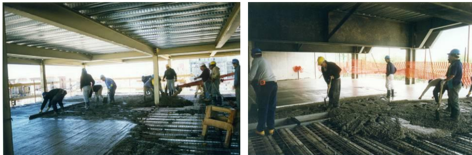
Figura 40 – Proceso de hormigonado
