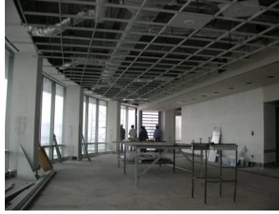
Figura 42 – Montaje del cielorraso
