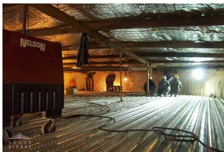
Figura 53 – Soldadura de conectores Nelson
