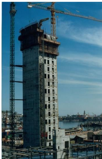
Figura 36 – Construcción del núcleo de hormigón
