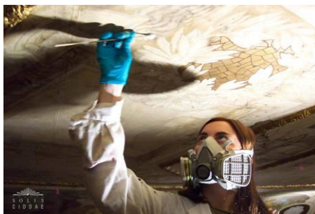
Figura 58 - Restauración del plafond
