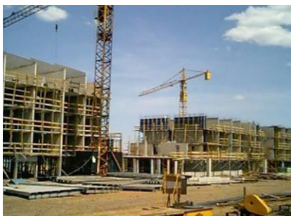
Figura 29 – Fotografía de la obra
