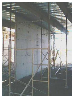
Figura 30 - Detalle del apuntalamiento
