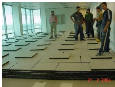
Figura 35 – Prueba de carga
