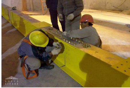
Figura 55 – Abulonado de las vigas
