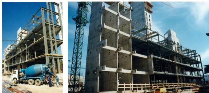
Figura 39 – Montaje del steel deck en el Edificio de Usuarios
