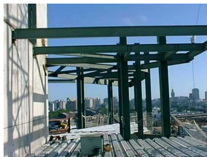
Figura 38 – Montaje del Steel deck en la Torre
