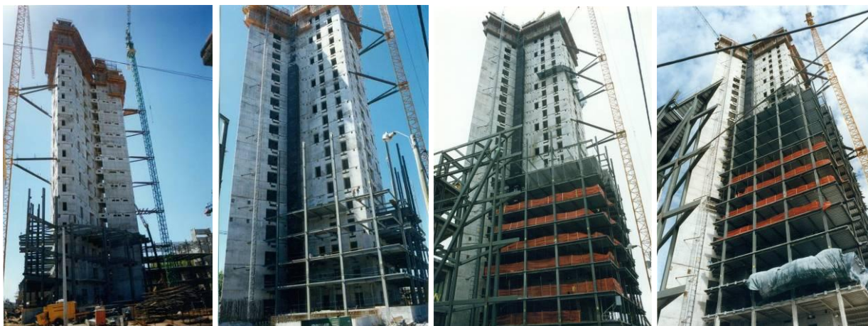
Figura 37 – Construcción de la estructura metálica
