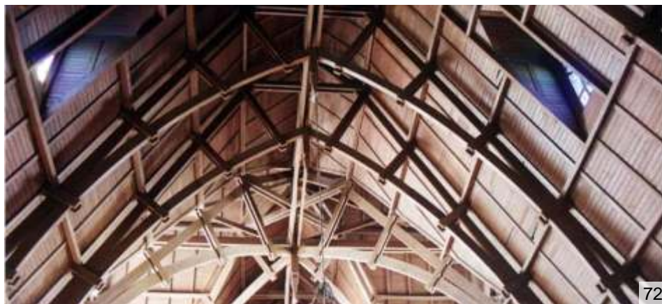
70: Detalle pilar del pórtico de la cubierta.
