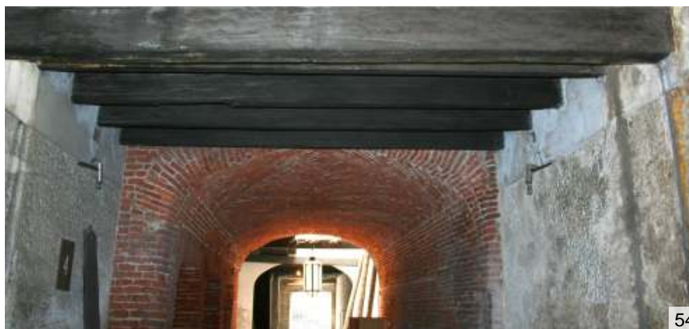
52: Techo a la porteña con vigas de troncos de palma del Paraguay.
