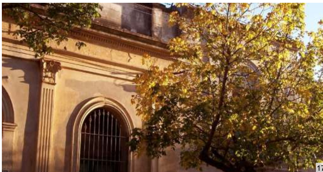
15: Fachada típica de casa patio 16: Interior reformado 17: Detalle de fachada
