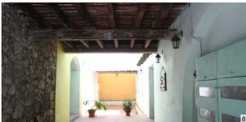
79: Detalle de techo a la porteña en acceso principal a cooperativa
