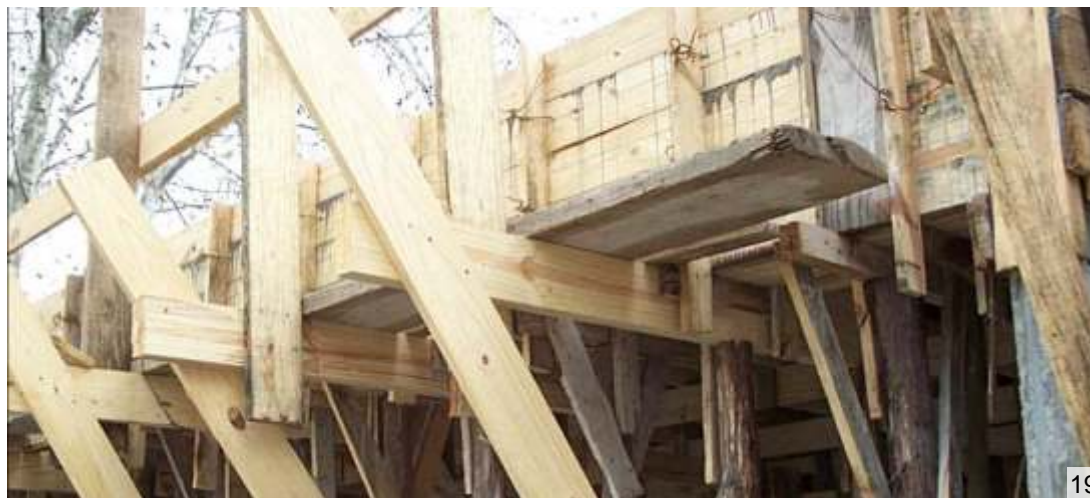
18: Obreros trabajando en la carpintería del encofrado de pino nacional
