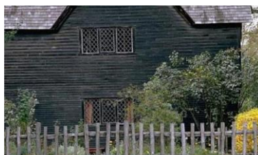
Madera Degradada por la acción de los rayos ultravioletas (la madera adquiere un característico color grisáceo).
