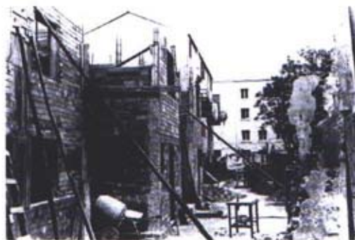
Bloques autotrabantes diseñados por el Arq. Muttoni. Cooperativa COVIGOES, Programa de la Intendencia de Montevideo, Instituto HACER-DESUR.
