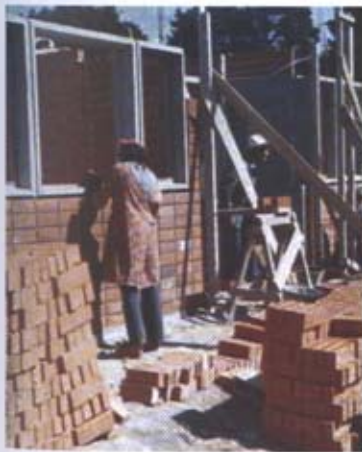
Mochetas premoldeadas con marcos incorporados. Instituto CCU.
