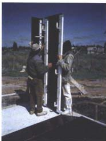
Paneles de poliestireno expandido con mallas electrosoldadas preparados en la planta de FUCVAM y cubiertos con mortero proyectado en obra. Cooperativa COVIFOEB e instituto COVIMA.
