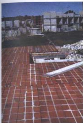
Prelosas de ladrillo armado antes del llenado de la carpeta de hormigón armado.
