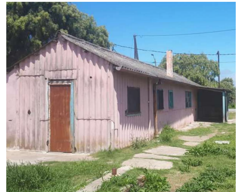
55 |> Sector de fachada edificio principal de la Estación Km 110. Fuente: Archivo Bianchi, E.
