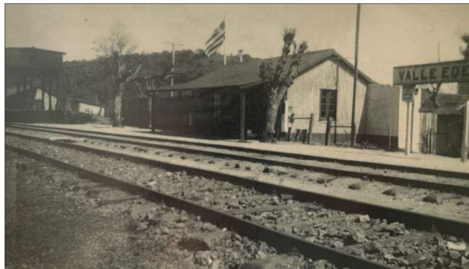
1. Fotografía del edificio principal de la estación (Fecha desconocida). Archivo Esc. Enrique Bianchi.
