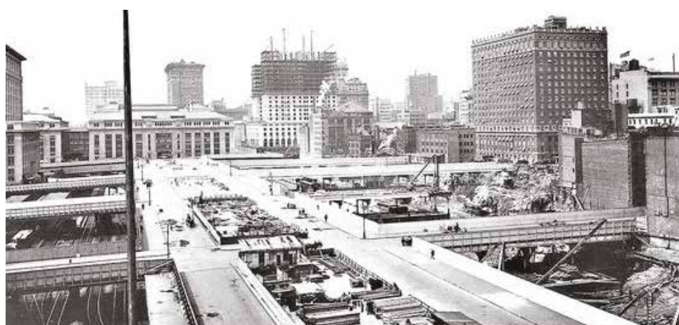
Fig. 4.7 Park Avenue y Grand Central en 1913. La grilla de calles y avenidas con las manzanas aún vacías dejan entrever las vías férreas en el nivel subterráneo. Al centro de la fotografía se aprecia otro edificio en construcción por detrás de una parte aún sin demoler de la vieja terminal.
