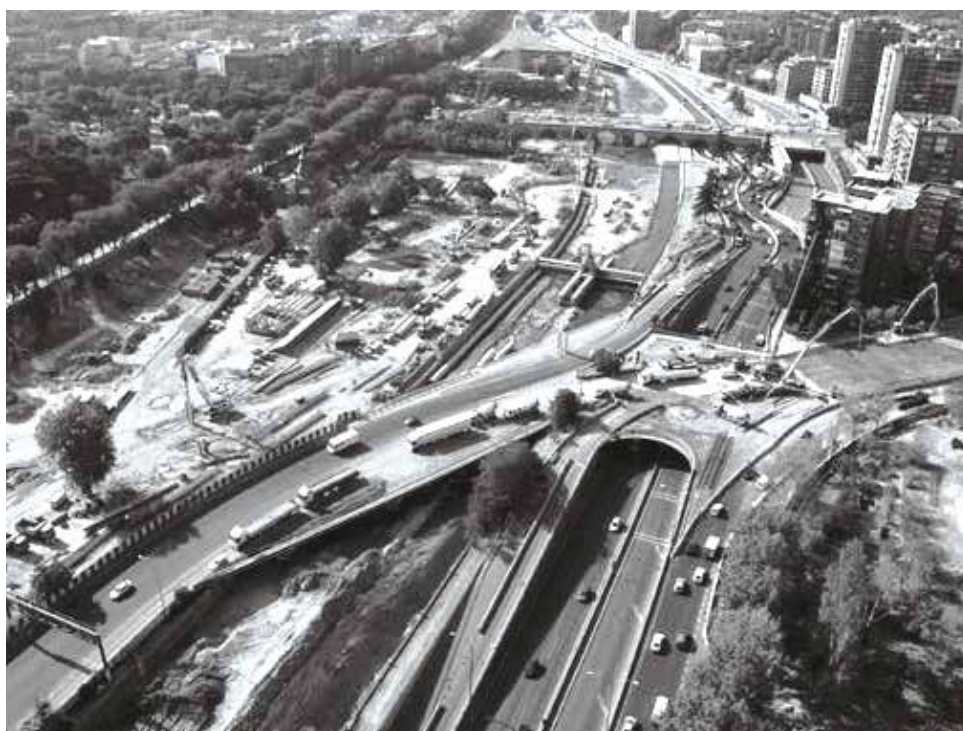
Fig.7.5 La M30 en el área del Puente Segovia, 2005.
