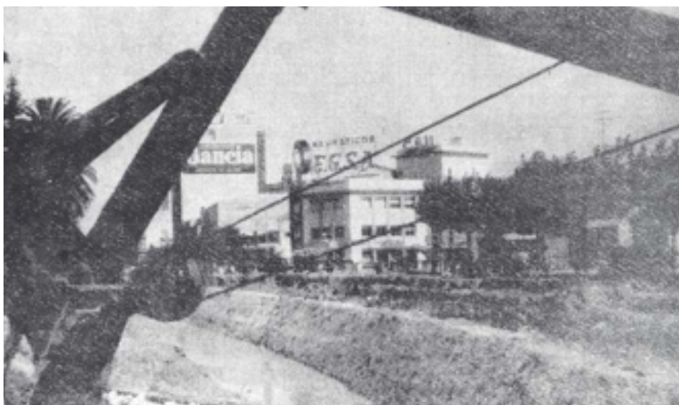
Fig. 8 Fotografía de la excavación para la construcción del Túnel de automotores de la Av. 8 de Octubre; en 1959; hacia la izquierda se aprecian las palmeras del arbolado de acceso al Hospital Italiano.
