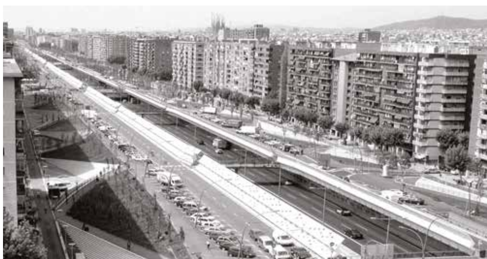
Fig. 7.16 Arriola & Fiol Arquitectos, la Gran Vía antes y después de la intervención que finalizó en el año 2007.
