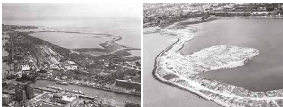
Fig. 7.2 Vista aérea de los terraplenes perimetrales del ensanche proyectado, 1980.
