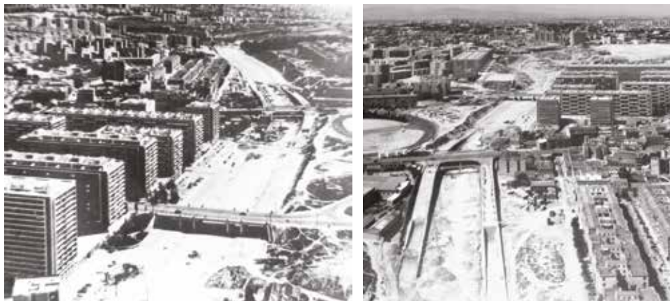
Fig.7.4 Construcción de la M30 a fines de los años '60.
