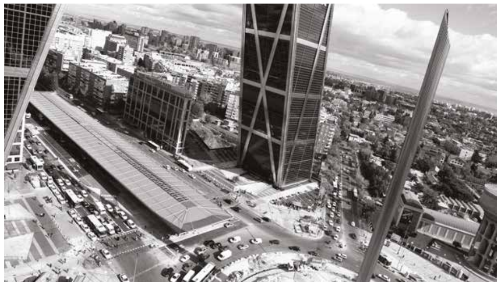
Fig.3.3 Intercambiador modal de Plaza de Castilla, Madrid, vista de la terminal de buses urbanos.
