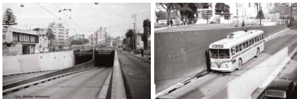
Fig. 9 1965 aprox. Acceso y salida del nuevo túnel de automotores visto desde la Avenida 8 de Octubre. Se aprecia el tendido eléctrico para la alimentación de los trolleys que ingresa en el túnel. A la derecha de la fotografía se pueden ver todavía en pie las edificaciones que luego serán demolidas para generar el espacio público proyectado.
