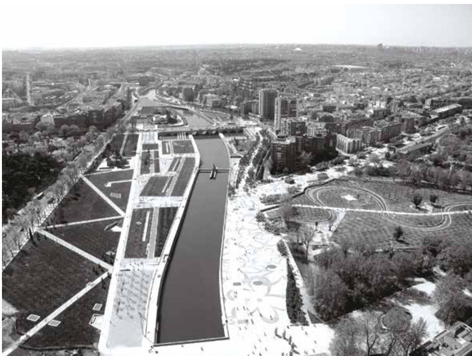
Fig.7.6 La M30 en el área del Puente Segovia en 2011.
