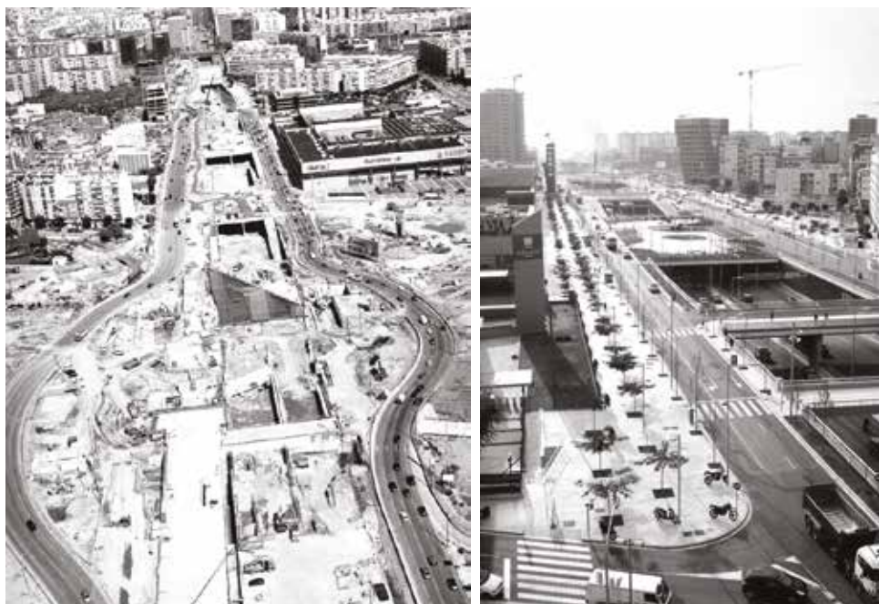
Fig. 7.18 Av. Gran Vía de l'Hospitalet de Llobregat durante su construcción y su aspecto luego de finalizadas las obras año 2009.
