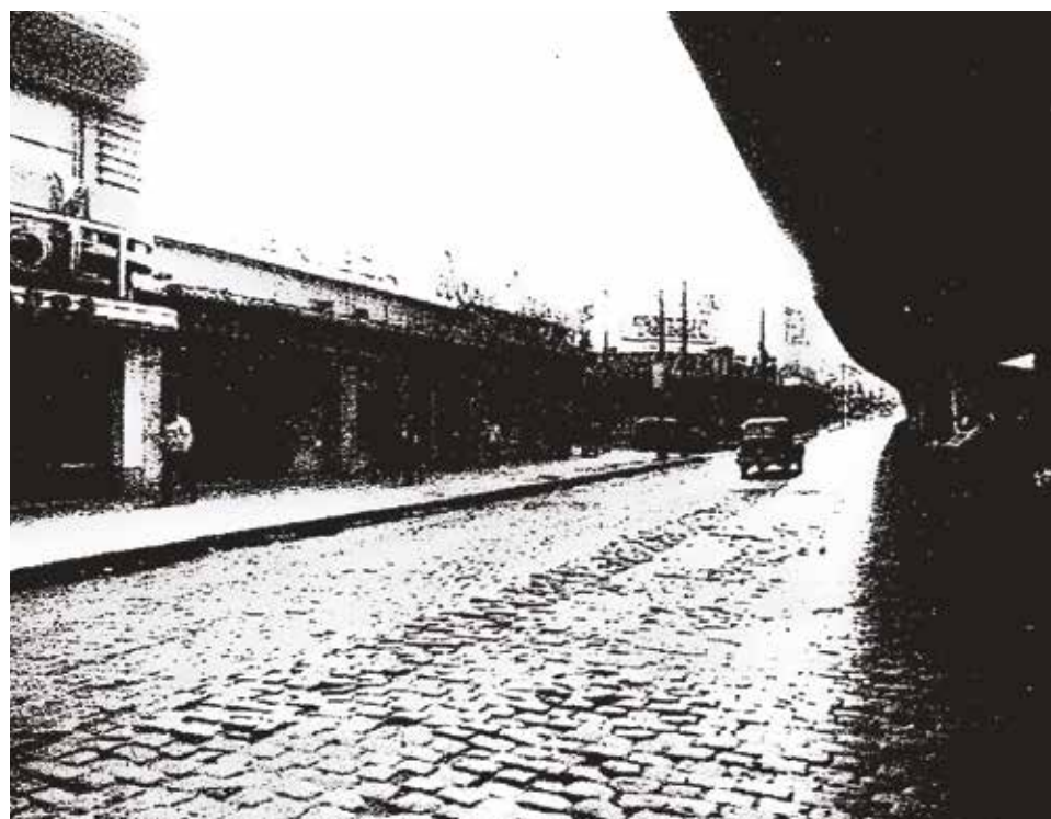
Fig. 3 El Viaducto de Paso Molino pocos años después de su inauguración en 1970. Contrasta la escala del barrio con la pieza infraestructural.
