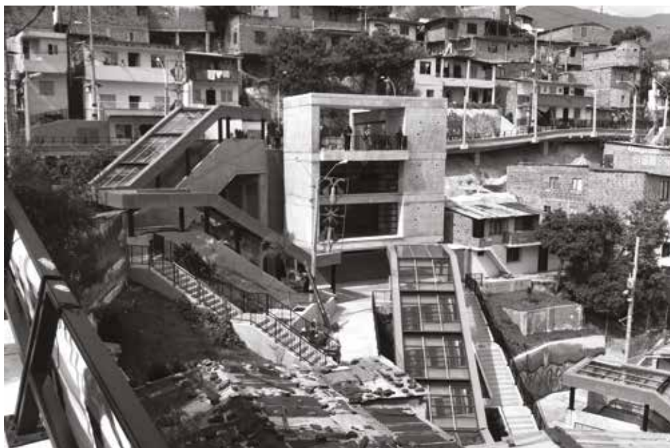
Fig. 3 a) Proyecto Urbano Integral Comuna 13. Escaleras mecánicas urbanas y equipamiento social integrado en una zona de difícil acceso y circulación, Medellín, 2008.
