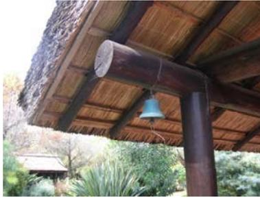
Casa Lorente. Detalle de la estructura de rollos de eucaliptos.
