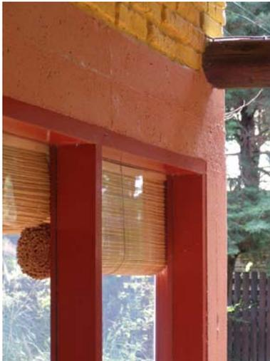
Casa Lorente. Detalle de dintel de hormigón armado visto y muro de ladrillo visto, coloreados.
