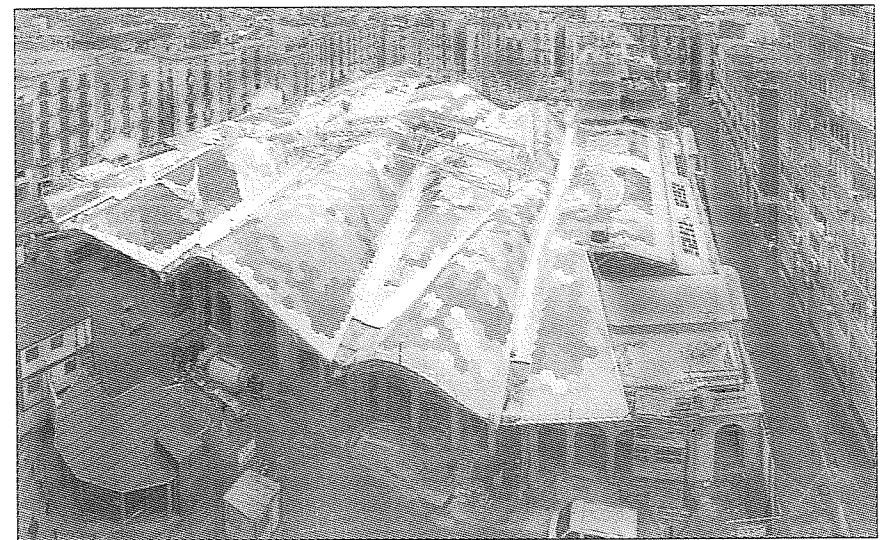
Figura 11.10. Reconstrucción del mercado de Santa Caterina a cargo de Enric Miralles y Benedetta Tagliabue. Los hexágonos pavimentan, por selección cultural, la compleja cubierta ondulada (fotografía de Benedetta Tagliabue).
