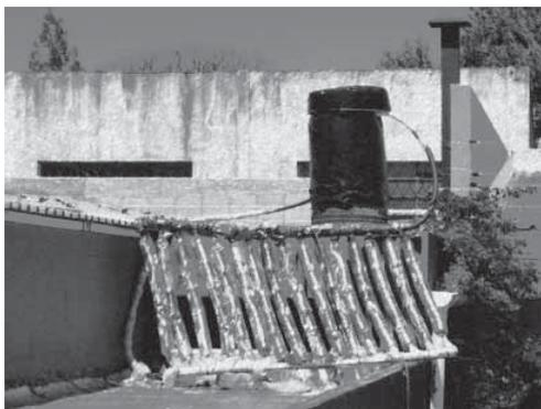
Colector dinámico de botellas instalado en el local de Tacurú
