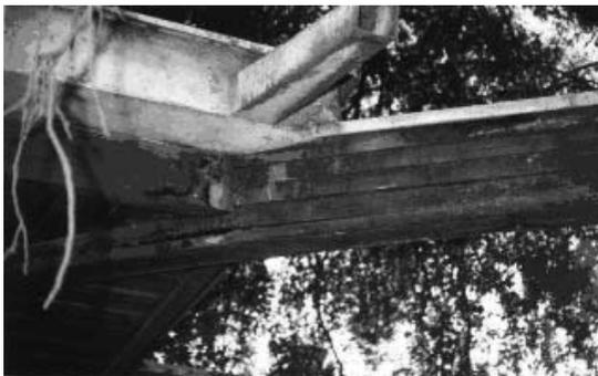
Fig. 1 – Comienzo de delaminación en viga con zona afectada por hongos
