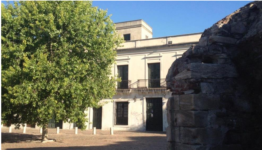
Fig.4- Casa de los Ximenez con mirador en a la bahía, vista actual
