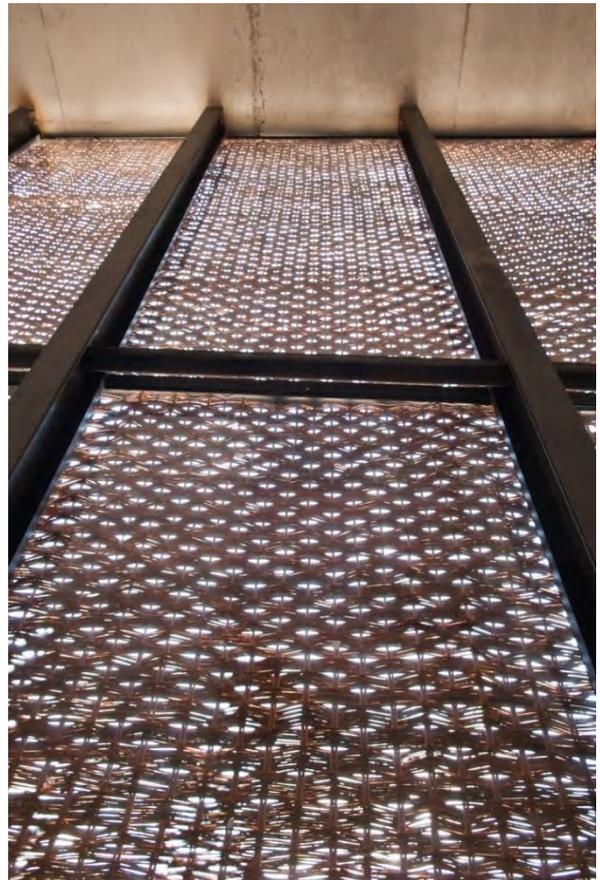
Izquierda, arriba y medio 69] y 70] paneles de resina con fibras de mimbre encapsuladas, para la línea de 3Form Varia de Hunter Douglas, The Andes House.
