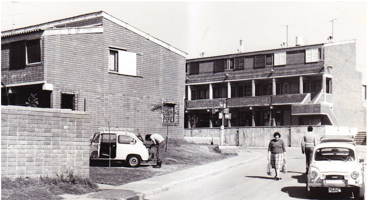
Img02: Complejo Intercooperativo Mesa 1 “Nuevo Amanecer” (Fuente: CCU)
