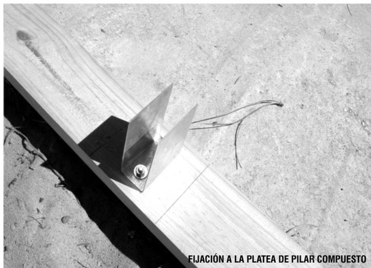
**FIJACIÓN A LA PLATEA DE PILAR COMPUESTO**
