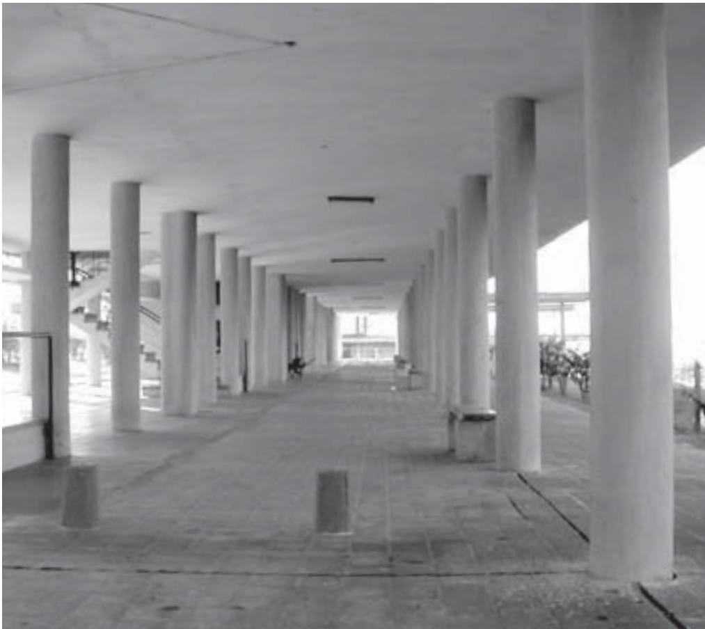
<|2H| Imagen actual de la Planta Baja de la Unidad de Habitación Cerro Sur.
