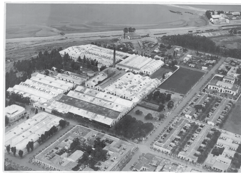
FIGURA 8. FOTOGRAFÍA DE LAS INSTALACIONES DE LA INDUSTRIAL EN 1946. AUTOR: DE GRANDI. BIBLIOTECA NACIONAL, COLECCIÓN DE FOTOGRAFÍAS ANÍBAL BARRIOS PINTOS. DISPONIBLE EN HTTP://BIBLIOTECADIGITAL.BIBNA.GUB.UY:8080/JSPIU/HANDLE/123456789/9220
