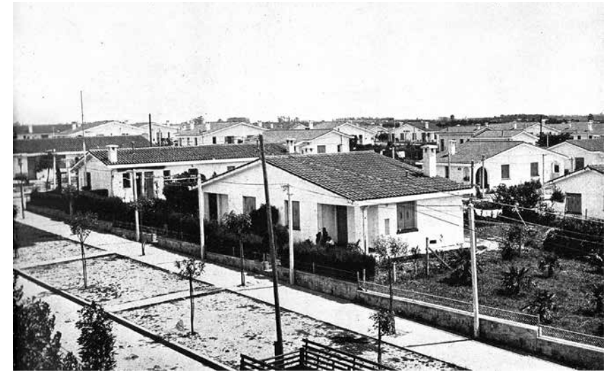
FIGURA 4. FOTOGRAFÍA DEL BARRIO 1. MEMORIA DEL INVE, 1942, P. 21.
