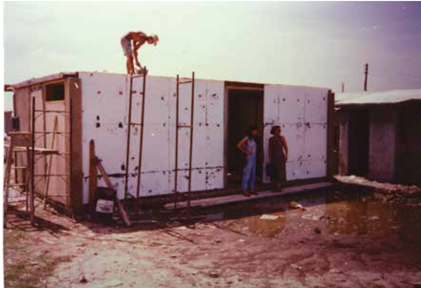
FIGURA 6. SISTEMA REALIZADO POR K.S. CONSTRUCCIONES EN LAS UNIDADES 1 Y 2. ARCHIVO DEL IT, FADU, UDELAR.
