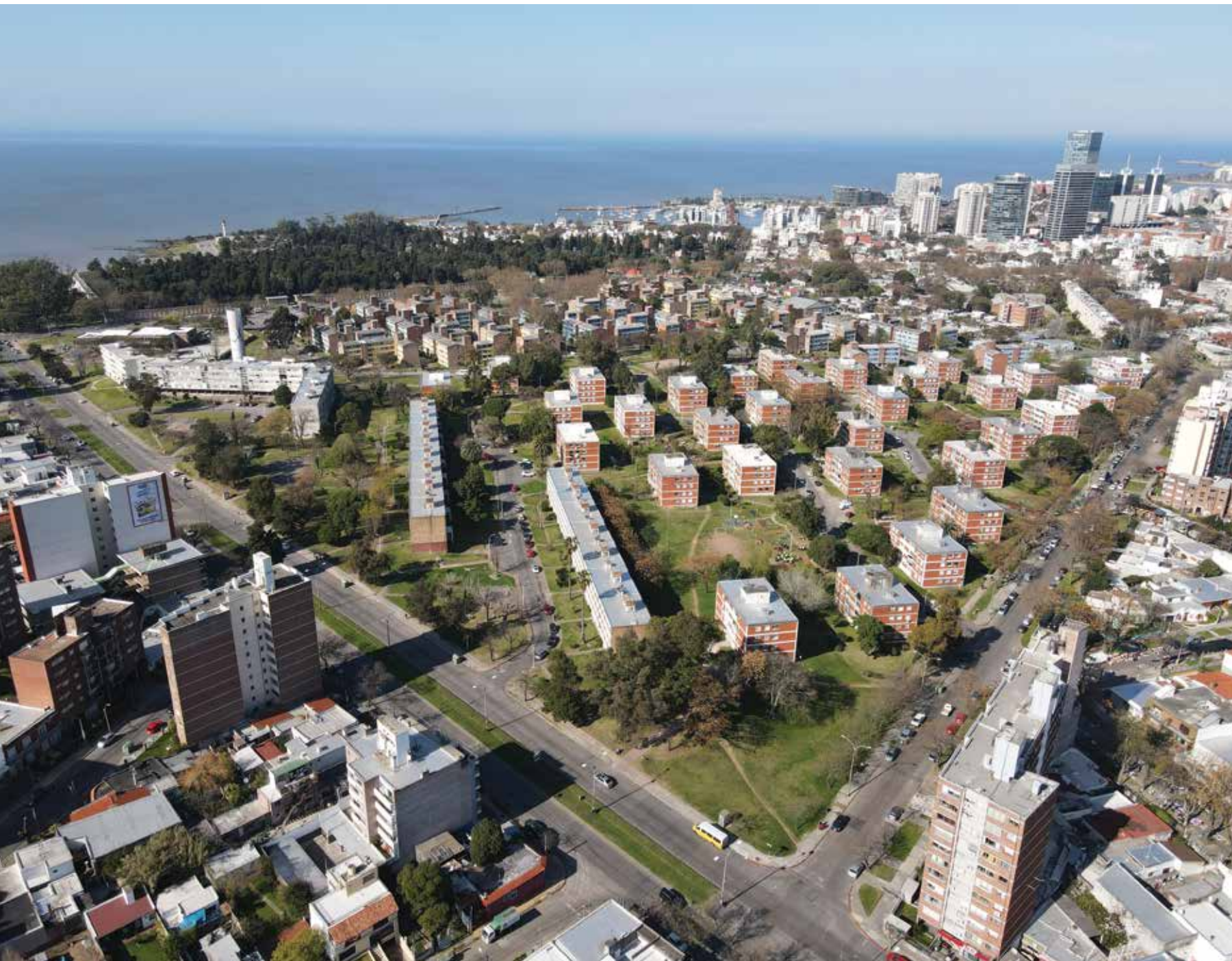
VISTA AÉREA TOMADA A VUELO DE DRON DESDE EL NORTE. FOTOGRAFÍA: MARTÍN CAJADE, 2022
