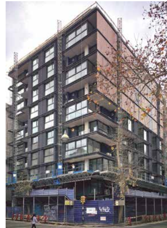
FIGURA 8. VISTA DE LA CONSTRUCCIÓN DEL EDIFICIO ALMA BRAVA, PROYECTO DE MATHIAS KLOTZ. FOTOGRAFÍA: PABLO CANÉN, 2019.
