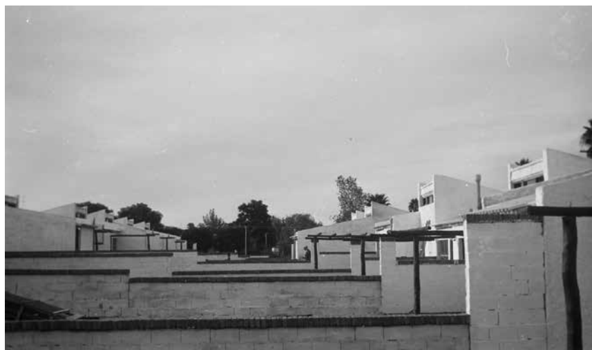
FIGURA 17. VISTA DE LOS PATIOS TRASEROS DEL CONJUNTO DE LA COOPERATIVA COSVAM EN SALTO. FONDO MARIO SPALLANZANI, CENTRO DE DOCUMENTACIÓN DEL IH, FADU, UDELAR.
