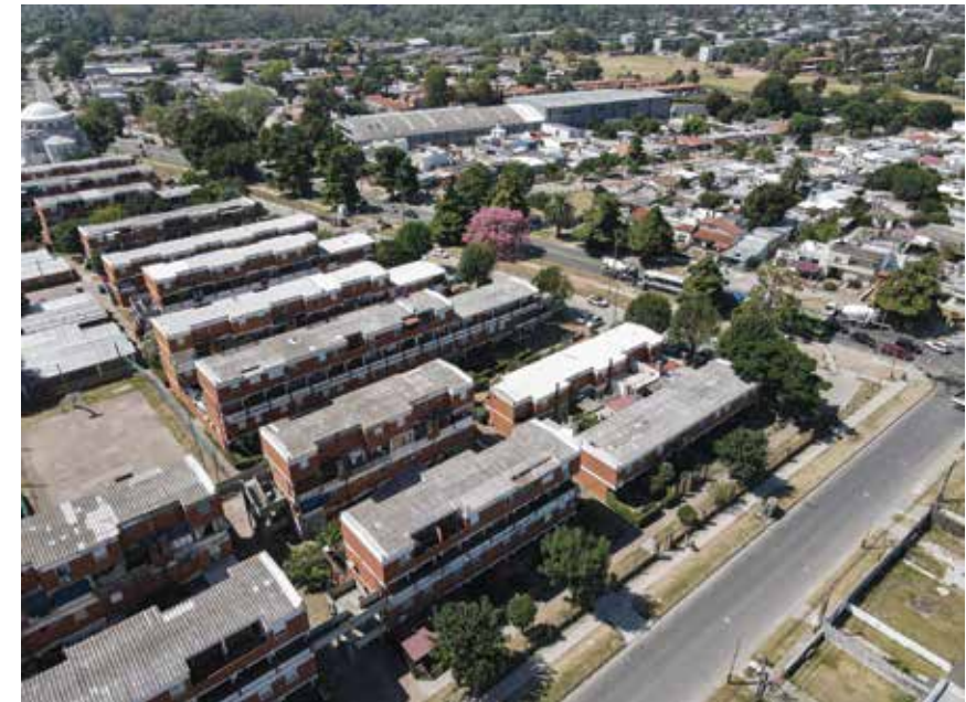
FIGURA 21. COOPERATIVA JOSÉ PEDRO VARELA, ZONA 6. VISTA DEL CONJUNTO, CON LAS CALLES ELEVADAS EN LAS TIRAS DE DÚPLEX SOBRE DÚPLEX. FOTOGRAFÍA: MARTÍN CAJADE, 2023.
