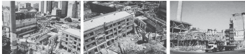
FIGURA 14. FOTOGRAFÍAS DE LA OBRA DE LOS AUTORES PUBLICADAS EN MODOS. REVISTA DE ARQUITECTURA DE LA UNIVERSIDAD ABIERTA INTERAMERICANA , N.º 04 Y 05, 2015.
