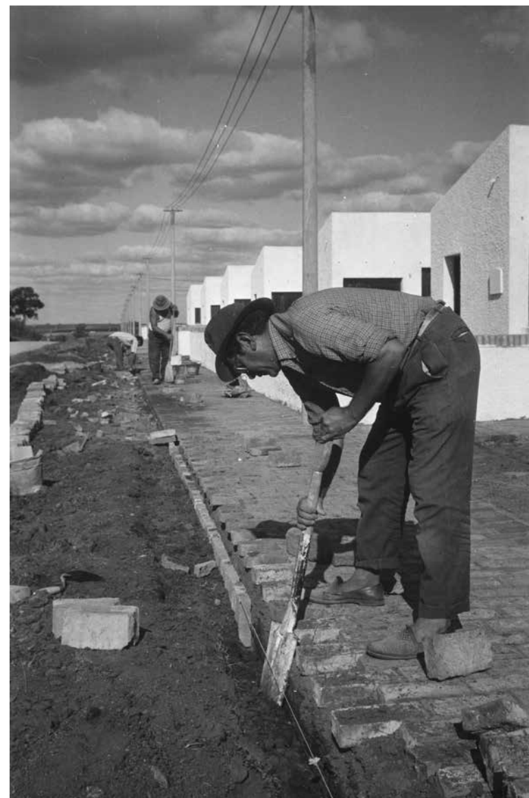
FIGURA 14. COOPERATIVISTAS EN LA ETAPA FINAL DE LA CONSTRUCCIÓN DE LA COOPERATIVA 25 DE MAYO, EN FLORIDA. CENTRO DE DOCUMENTACIÓN DEL IH, FADU, UDELAR.
