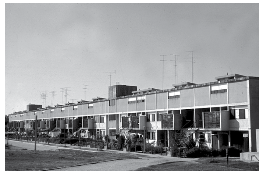
FIGURA 4. VISTA DE UNO DE LOS BLOQUES DEL BARRIO 16 DEL INVE. FOTOGRAFÍA: SERVICIOS DE MEDIOS AUDIOVISUALES, FADU-UDELAR.
