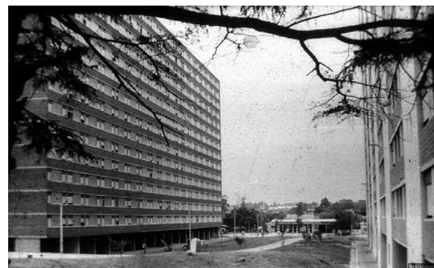
FIGURA 10. FOTOGRAFÍA DEL PARQUE POSADAS. SERVICIO DE MEDIOS AUDIOVISUALES, FADU, UDELAR. FOTO 28376.
