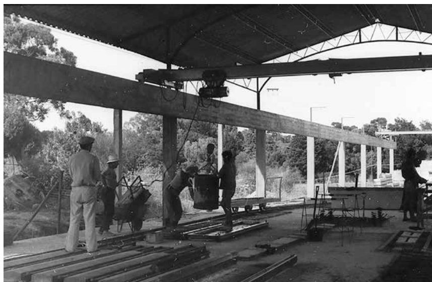
FIGURA 22. COOPERATIVISTAS EN LA PLANTA DE PREFABRICADOS UBICADA EN LA ZONA 3 DEL CONJUNTO JOSÉ PEDRO VARELA. FONDO CUBRÍA, CENTRO DE DOCUMENTACIÓN DEL IH, FADU, UDELAR.
