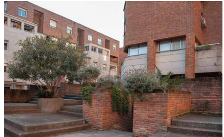
VISTA PEATONAL DE LOS JARDINES INTERIORES. FOTOGRAFÍA: MARÍA NOEL VIANA, 2022
