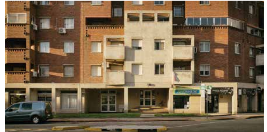
FIGURA 4. VISTA A NIVEL DE PEATÓN POR LA CALLE ING. C. M. MORALES. PLANTA BAJA CON PASIVAS Y ESPACIOS DE ACCESO CON REVOQUE IMITACIÓN, CONTRASTADOS CON MUROS DE LADRILLO DEL PROPIO CONJUNTO. FOTOGRAFÍA: PABLO CANÉN, 2021.
