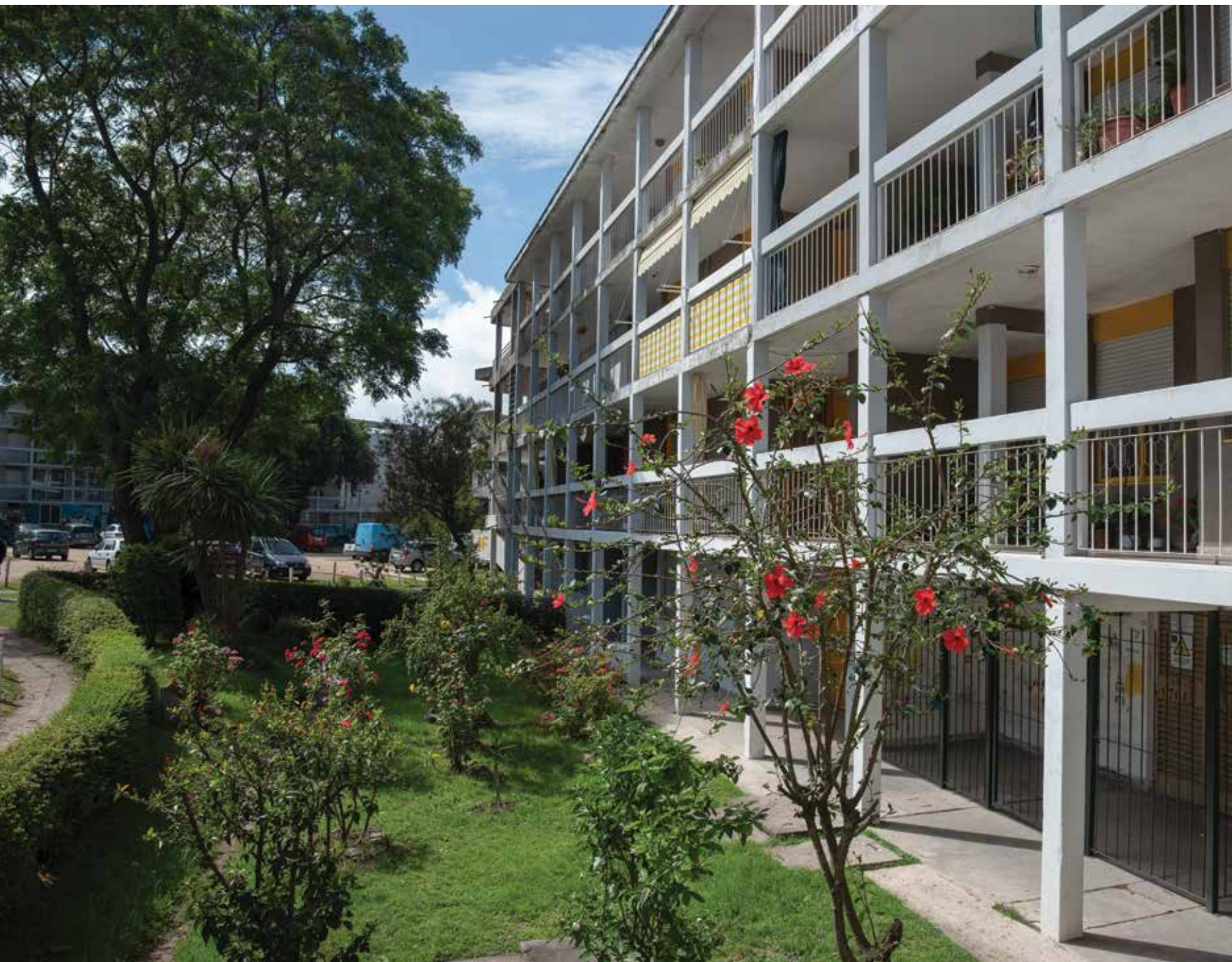
VISTA PEATONAL, DETALLE DE LOS PATIOS FORMADOS POR LOS BLOQUES Y LAS CALLES ELEVADAS. FOTOGRAFÍA: MARÍA NOEL VIANA, 2022
