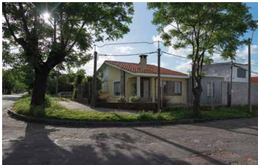
VISTA PEATONAL DE UNA DE LAS UNIDADES EN ESQUINA. FOTOGRAFÍA: MARÍA NOEL VIANA, 2022
