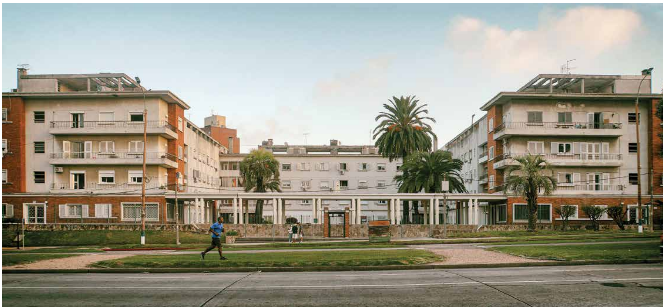
VISTA PEATONAL DEL CONJUNTO, DESDE EL NORTE, POR AVENIDA ITALIA. FOTOGRAFÍA: PABLO CANÉN, 2021
