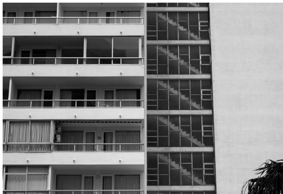
Edificio Península. | SMA-S303-129, SMA-S303-146, SMA-S303-151.
