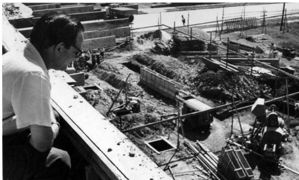
Villegas Berro en la obra del Edificio Península. | CD-IH. Fondo Villegas Berro.
